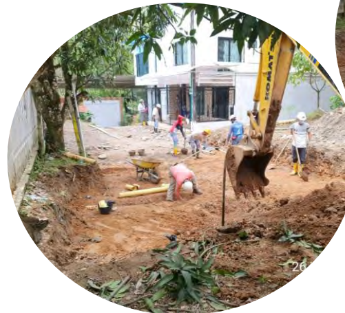
Cajeo de vía para instalación de geotextil y pedraplén
