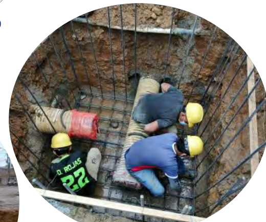
Construcción de cámara de inspección red pluvial
