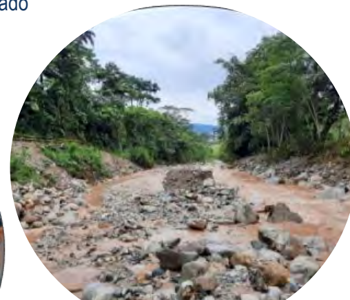
Lavado del material conformado y colmatación sobre las cotas de fundación debido a las crecientes del río Sangoyaco.
