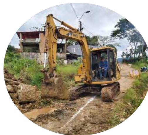
Instalación de tubería 12" para red lluvia
