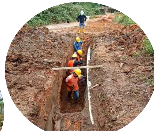
Instalación de tubería 12" para red lluvia
