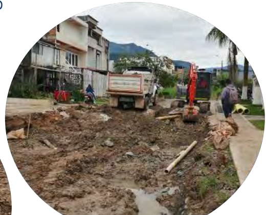
Cajeo de la vía, instalación de geotextil y pedraplén
