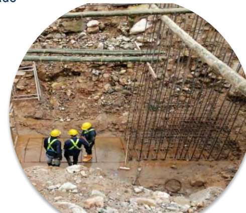
Armado Acero Dentellón
