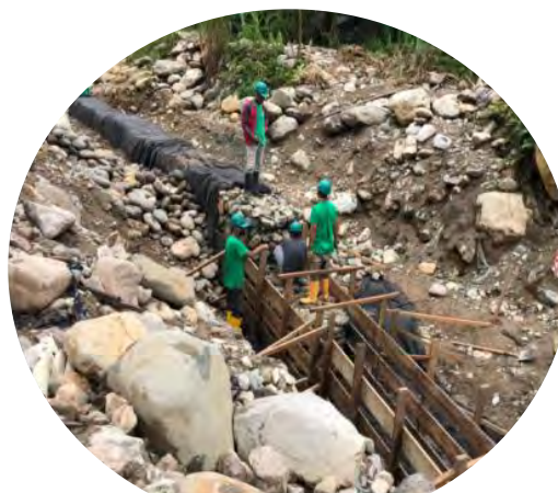
Construcción de gabi6n de muro 7
