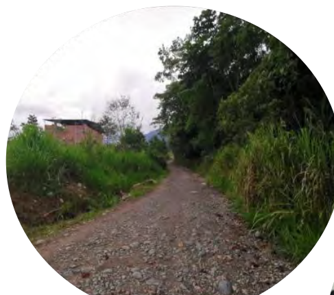
Estado inicial de la vía a intervenir
