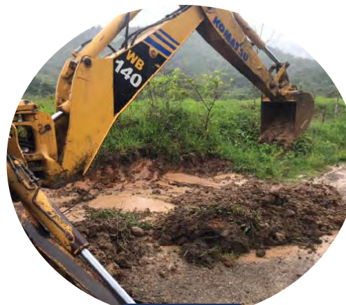
Limpieza de vía
