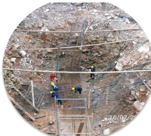
Armado Acero Dentellón
