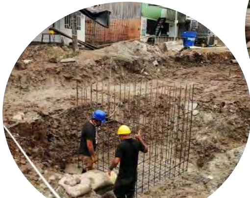
Construcción cámara de inspección para red pluvial
