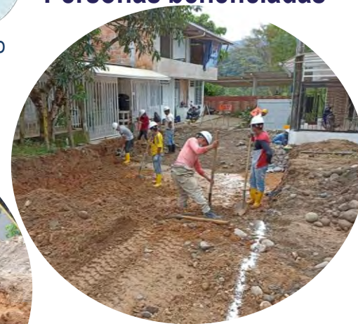
Cajeo de vía para instalación de geotextil y pedraplén
