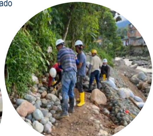
Colocación de piedra para el colcha gavión del muro n°6
