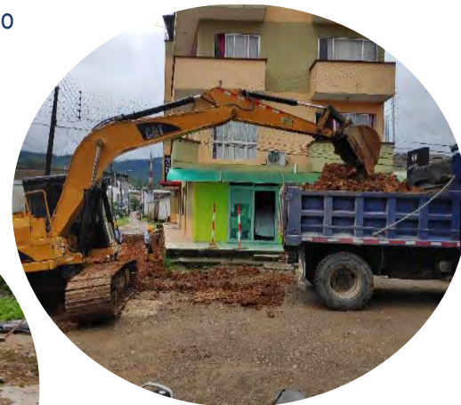
Cajeo de la vía, instalación de geotextil y pedraplén
