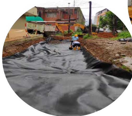
Cajeo de la vía, instalación de geotextil y pedraplén
