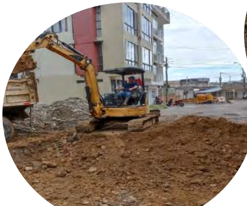
Cajeo de vía para instalación de geotextil y pedraplén
