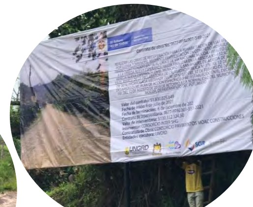
Instalación de valla
