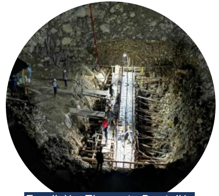
Fundición Elemento Dentellón
