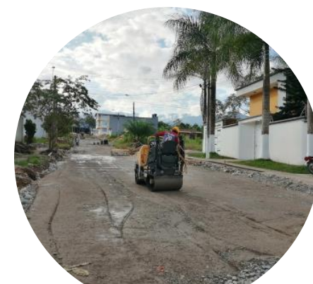
Compactación de sub-base
