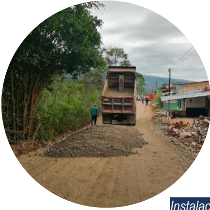
Instalación de material de mejoramiento
