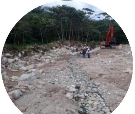
Rellenos y conformación de jarillón de protección para el Muro 7 – Río Mulato
