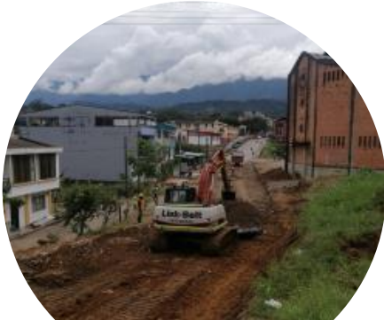
Terminación de cajeo sector ciudadela deportiva
