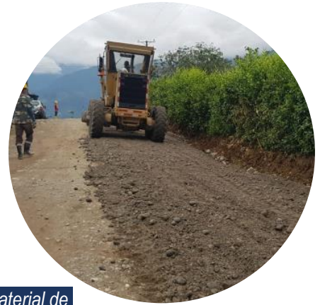
Instalación de material de mejoramiento
