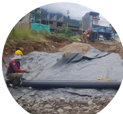
Instalación de geotextil y pedraplén
