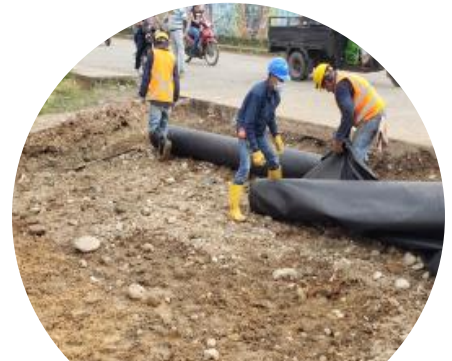
Instalación de geotextil ciudadela deportiva
