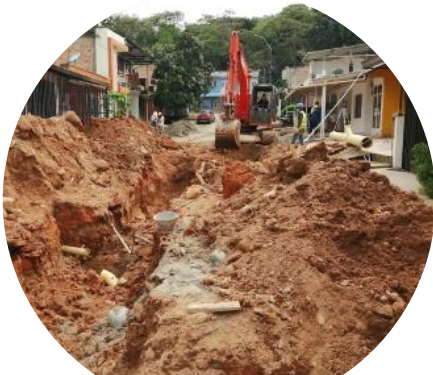
Construcción de cámaras de inspección y sumideros para red pluvial barrio El Carmen
