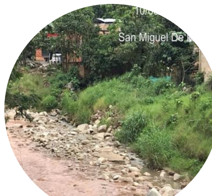
Topografía y replanteo del Muro 09
