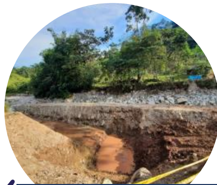
Excavación en roca bajo agua para la ubicación del dique
