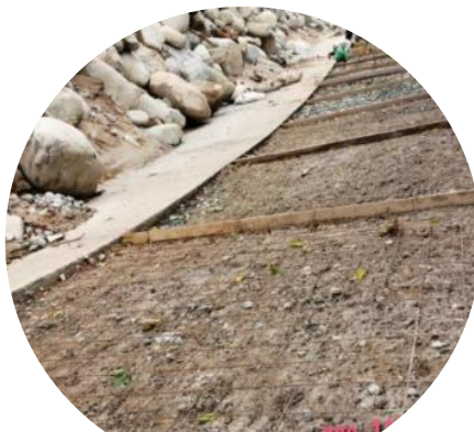
Instalación de formaletas y malla electrosoldada para losa de recubrimiento del muro N° 6
