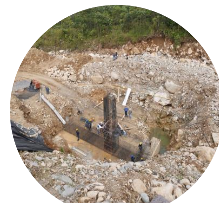
Armado de aceros y formaletas
