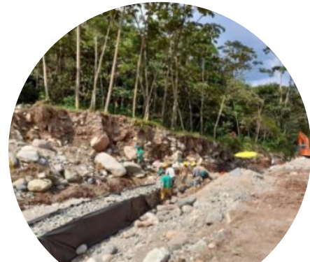
Construcción de gaviones Muro 7 - Río Mulato
