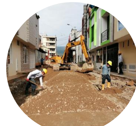
Excavación e instalación de material granular
