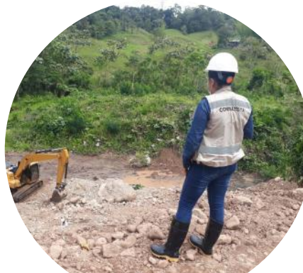
Inicio Excavaciones Azud 11
