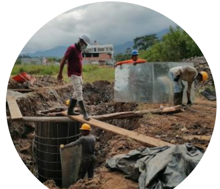
Instalación de formaleta para cámaras Prado Norte – Bajo Cañaveral
