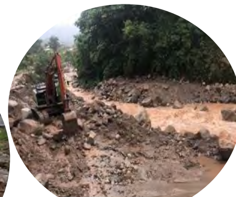
Construcción Dique Azud 13
