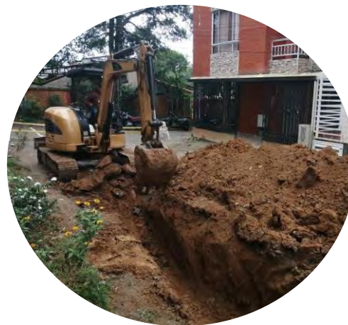
Instalación de tubería de 12" PVC para red de alcantarillado pluvial
