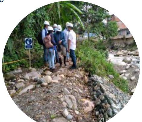
Visita de los especialistas del contratista de obra con la interventoría
