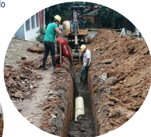
Instalación de tubería de 12" PVC para red de alcantarillado pluvial
