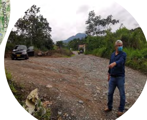
Estado inicial de la vía a intervenir
