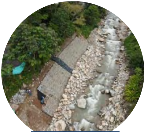
Construcción de colcho gaviones del muro No. 6
