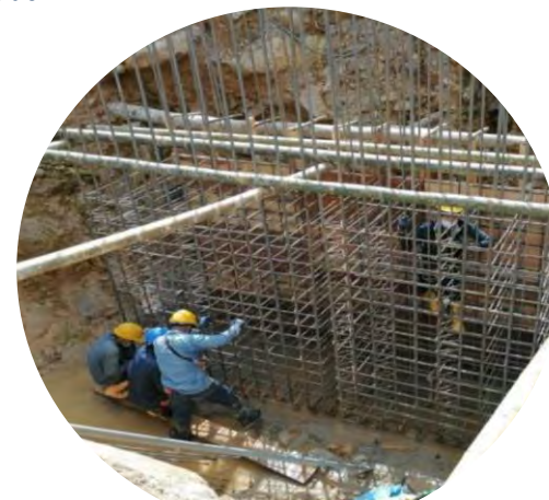
Armado de acero para dentellón
