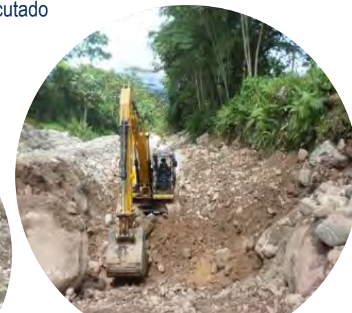
Excavación mecánica en material aluvial del cauce para desviación
