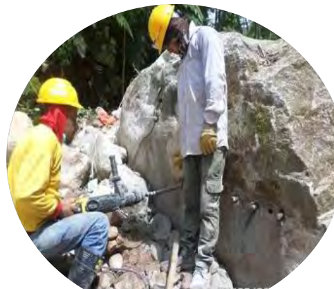
Fragmentación de rocas por el método manual con rotomartillo
