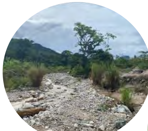
Visita de obra Azud 07 – Q. Taruca
