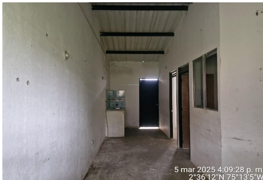
Fotografía No. 3 Interior de una de las habitaciones de la vivienda tipo del beneficiario DINAEL TOVAR PLAZAS en la vereda Andes Medios de Algeciras, la cual está deshabitada y no utilizada.
