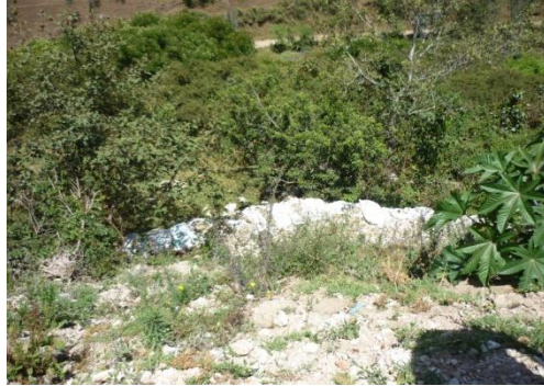
Riesgo de deslizamiento
