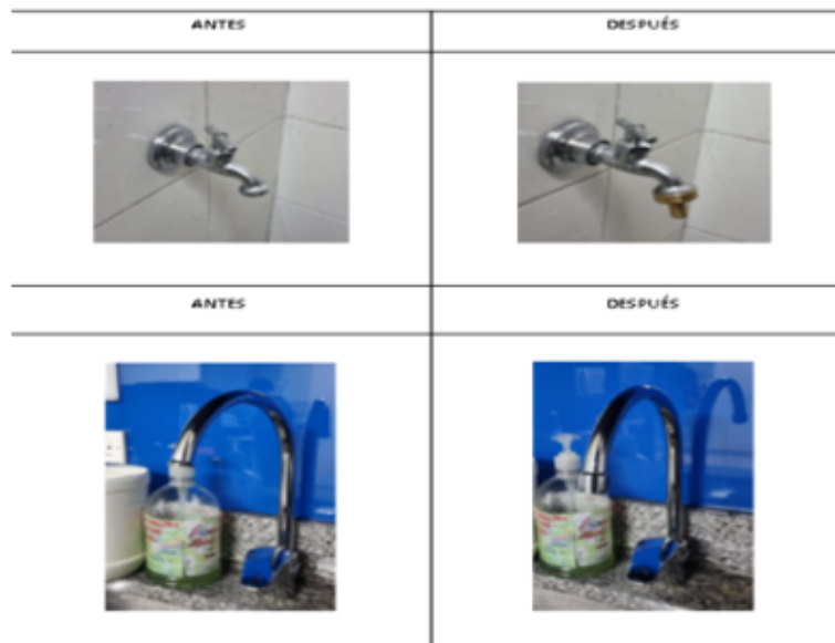
INSTALACIÓN DEL SISTEMA DE AHORRO DE AGUA PARA LAS LLAVES DE LA SEDE A
