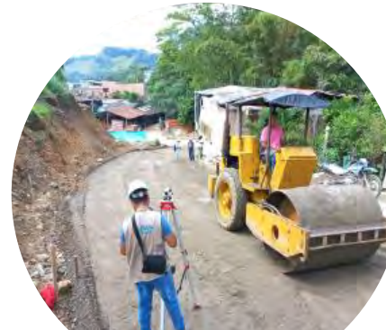
Instalación subbase Sector Ciudadela Deportiva
