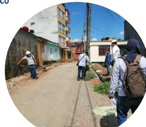
Visita técnica de Planeación y Empresa de Energía para movimiento de postes
