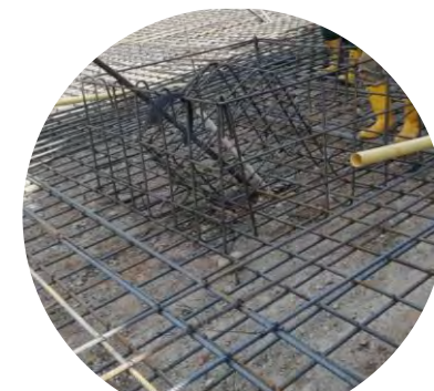
Armado de acero
