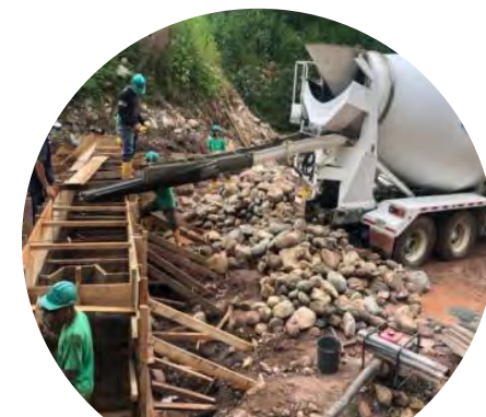
Fundición del dentellón del dique tipo azud 9
