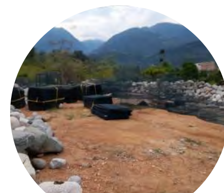
Adquisición material de construcción para Muro 06 y azud 12
