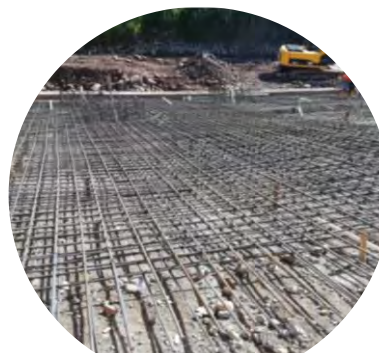
Armado de acero
