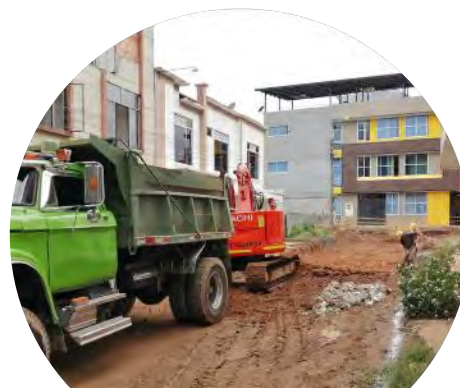
Excavación para instalación de geotextil y pedraplén
