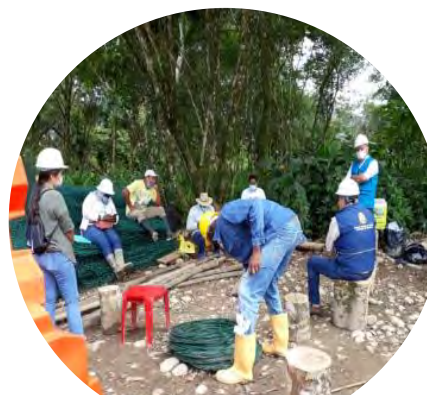
Comité técnico en obra
