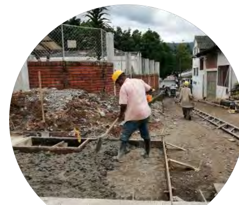
Fundición de placas en concreto
