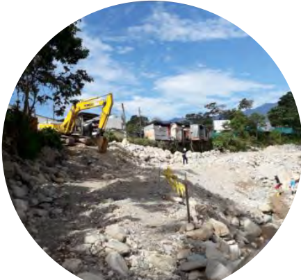
Conformación del talud del muro de protección 6
