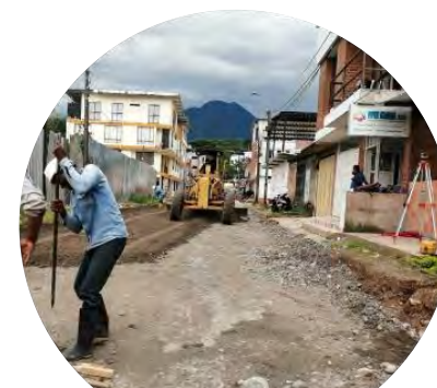
Instalación de subbase TRAMO IV
