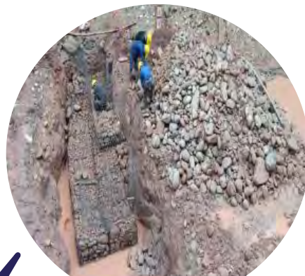
Construcción de gaviones
