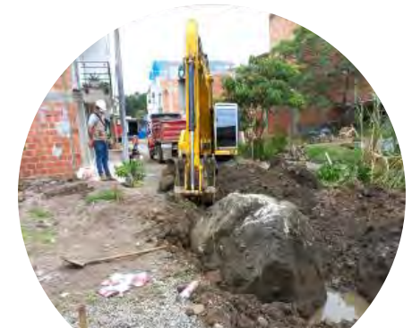
Intervención Tramo 9- B/ Quinta Paredes
