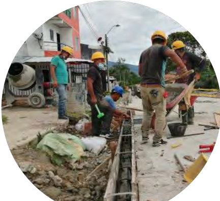
Fundición de bordillos
