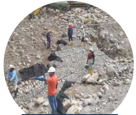
Construcción de colcha gavión para muro de protección 6
