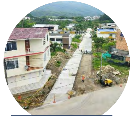
Fundición de placas de concreto
