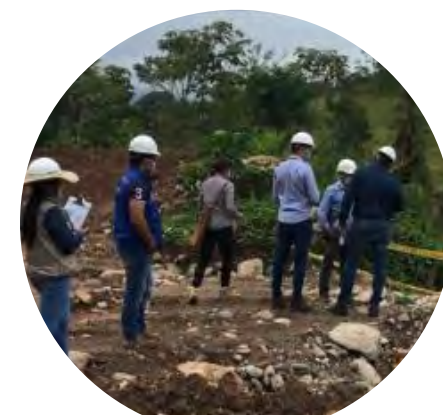
Visita de Contraloría en obra
