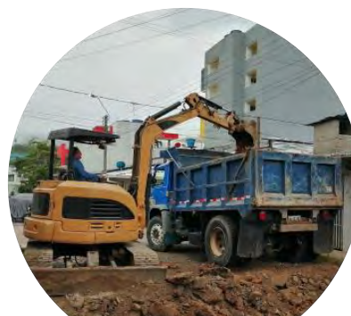
Excavación e instalación de geotextil TRAMO IV
