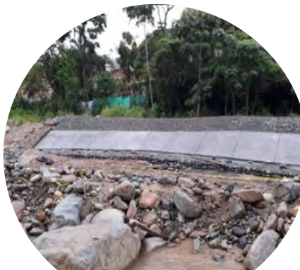
Construcción de placa del muro de protección 7
