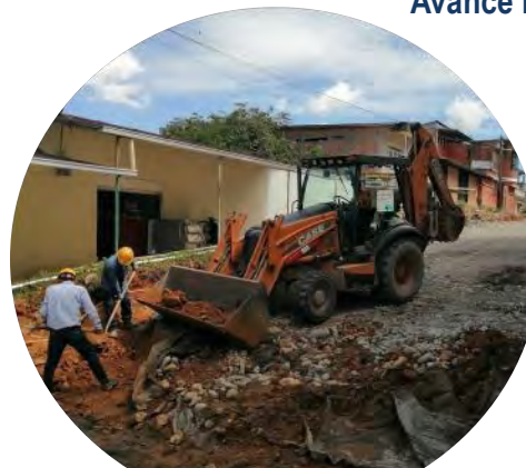
Instalación de geotextil y pedraplén
