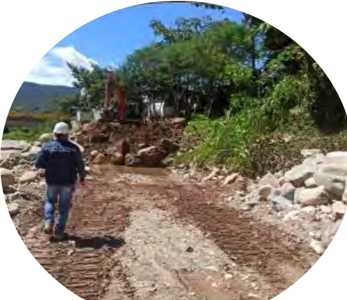
Construcción Dique Azud 13
