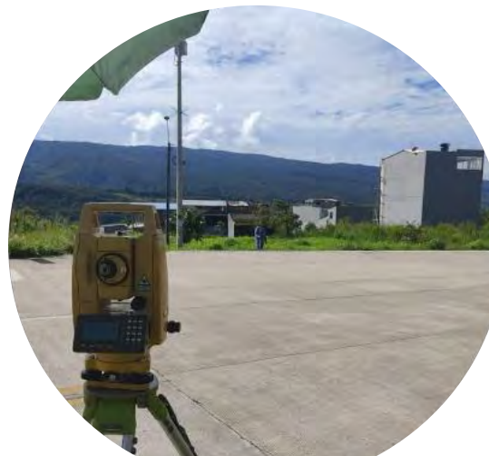
Verificación de topografía por parte de la interventoría
