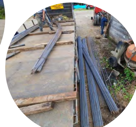
Acopio de material
