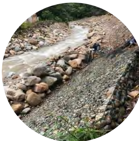
Construcción de colcho gaviones del muro No. 6
