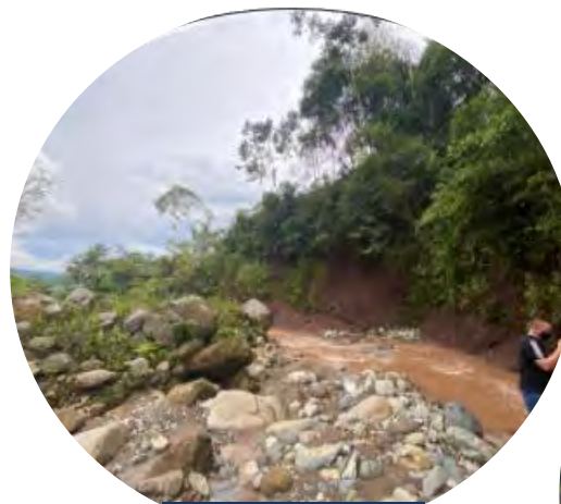
Visita de obra Muro 01
