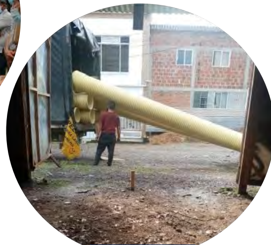
Llegada de material
