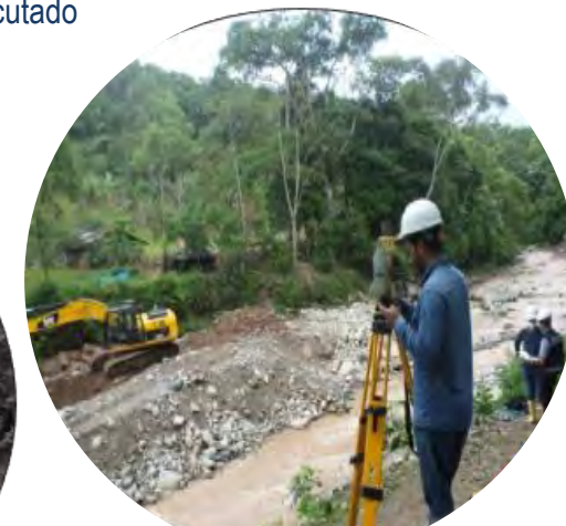
Excavaciones y control topográfico
