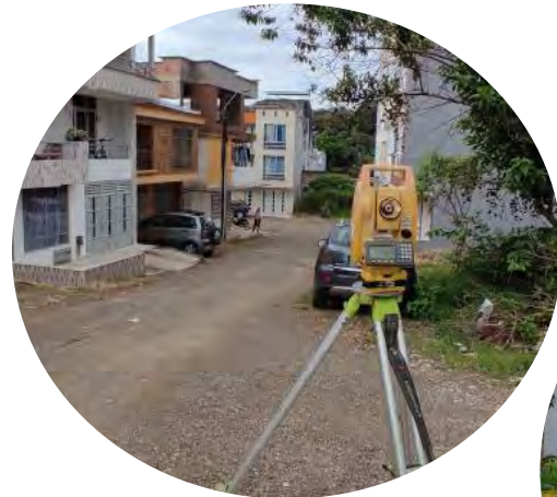
Verificación de topografía por parte de la interventoría
