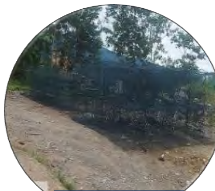
Consecución de mallas para gaviones
