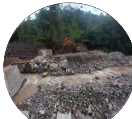
Adecuación de terreno para instalación de gaviones ribera derecha aguas arriba del dique
