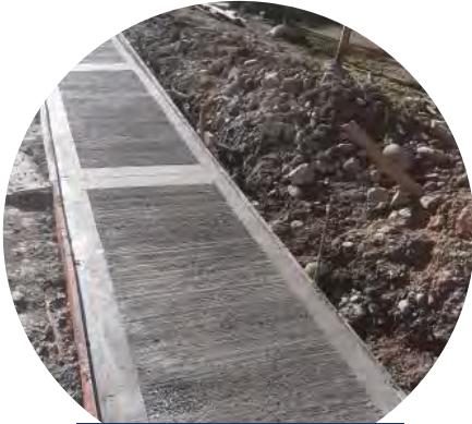
Fundición de placa andenes
