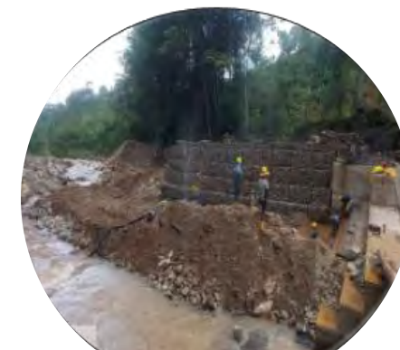
Instalación gaviones ribera derecha aguas abajo Dique
