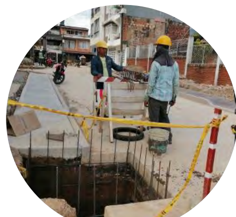
Fundición de sumideros
