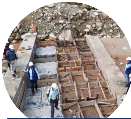
Instalación bolsacreto salida del azud 9
