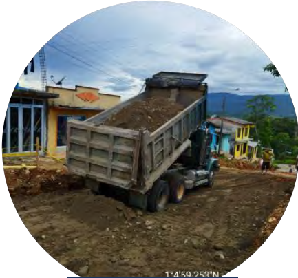
Mejoramiento de Suelo
