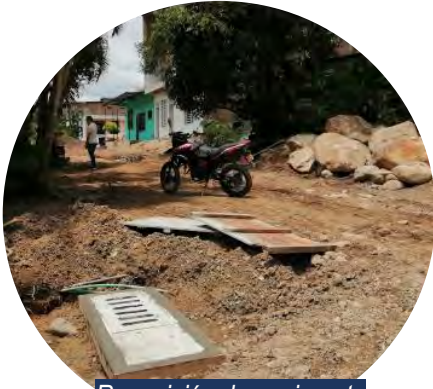
Reposición de pavimento barrio El Carmen
