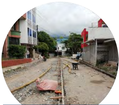
Instalación de formaleta para fundición de placas TRAMO IV
