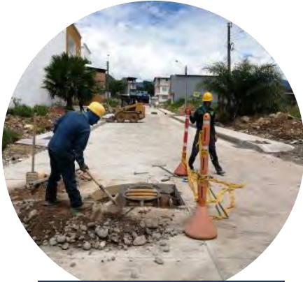
Nivelación de cámaras sanitarias
