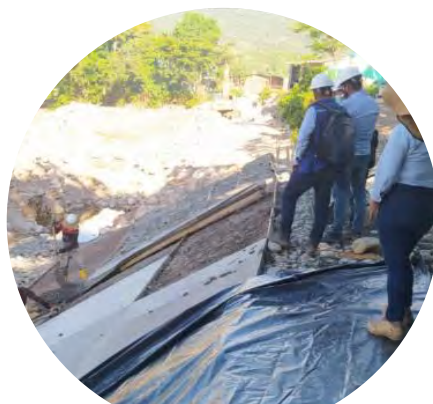
Visita de obra de contraloría y fundición de placa de protección de muro 6
