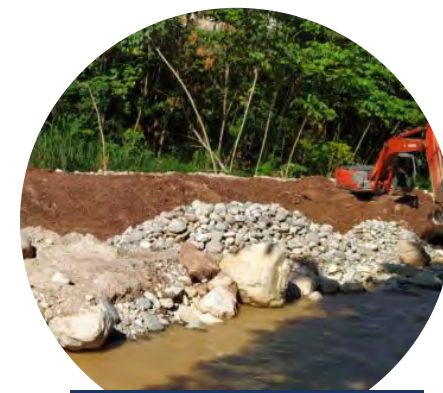
Conformación del talud del muro de protección 7
