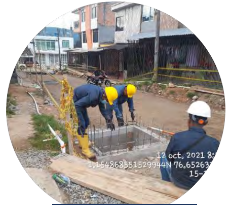
Sumideros Obrero Etapa II
