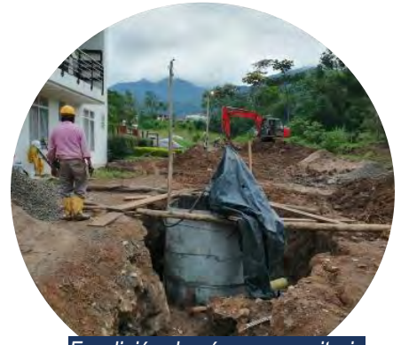
Fundición de cámaras sanitaria barrios Prado Norte – Bajo Cañaverál
