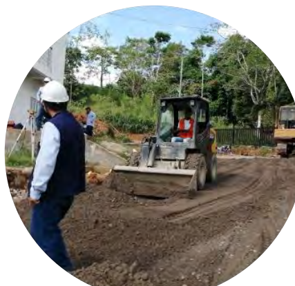
Instalación de subbase
