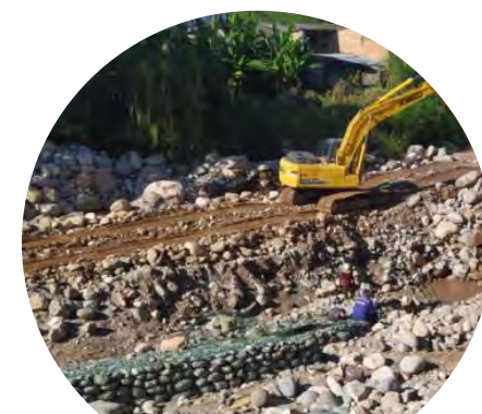
Construcción de colcha gavión para muro de protección 6 y conformación de carretables
