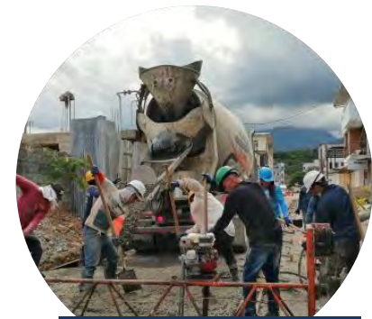
Fundición de placas TRAMO IV
