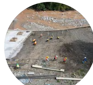
Armado de acero
