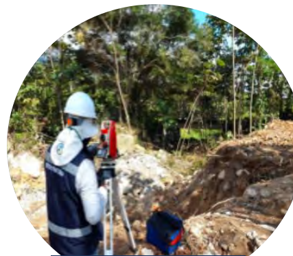
Levantamiento topográfico Azud 6- Muro 2
