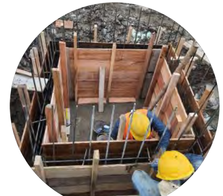
Fundición de cámaras B/ Quinta Paredes.
