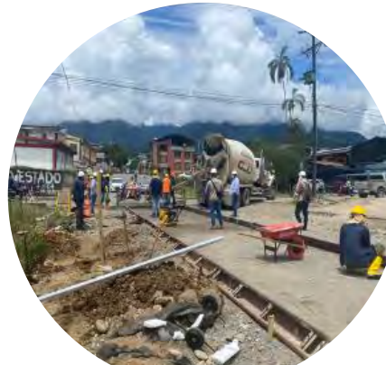
Pavimentación tramo 38 m. Barrio Olímpico.
