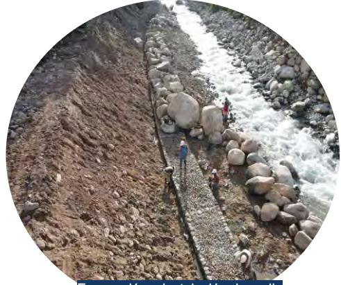
Excavación e instalación de malla gavión y geotextil
