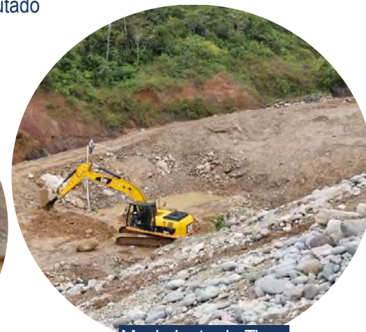
Movimiento de Tierra
