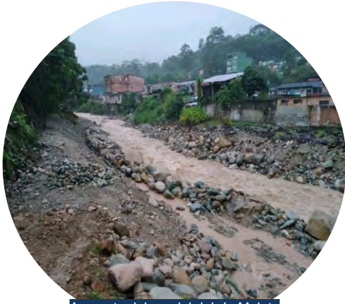
Aumento del caudal del río Mulato sin afectación sobre la obra
