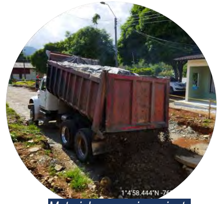
Material para mejoramiento
