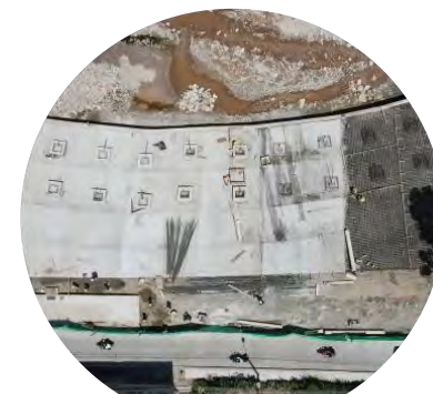
Armado de acero
