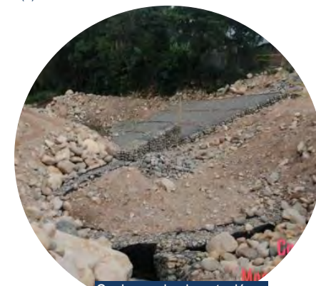
Gaviones de cimentación y relleno de espolón 2
