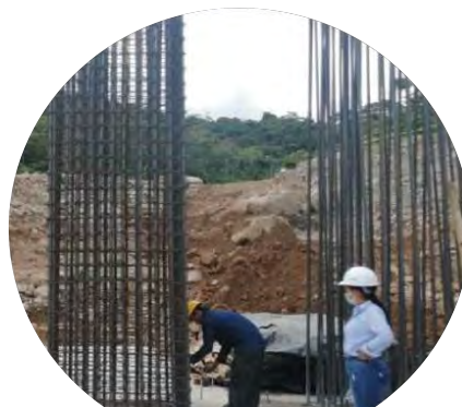
Instalación de estribos y ganchos
