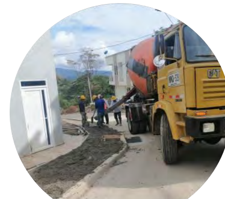
Fundición de andenes
