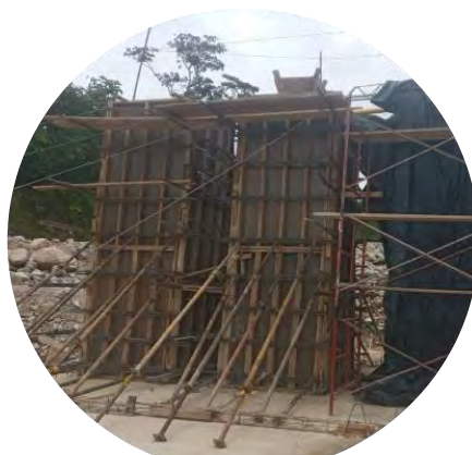
Instalación de formaleta y pasarelas tabique
