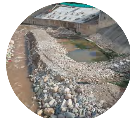
Construcción Jarillon protección Azud 15
