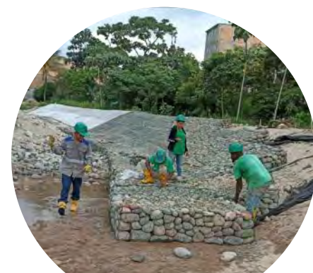
Instalación de colcha gaviones del muro de protección del muro 6
