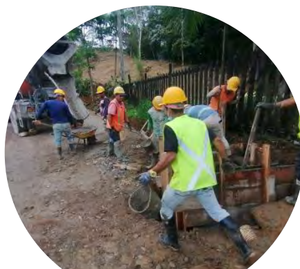
Construcción de sumideros y cámaras de inspección
