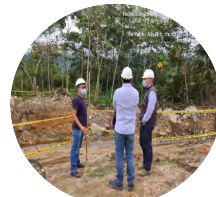
Visita técnica Geotecnista
