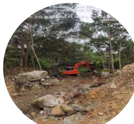
Descolmatación debajo de puente- Azud 6
