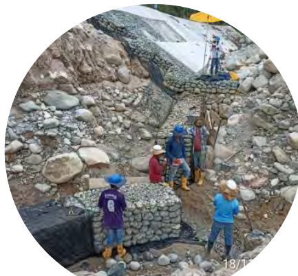
Gaviones de cimentación de espolón 1
