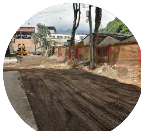
Instalación de subbase
