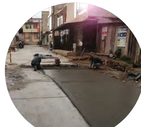
Fundición de placas
