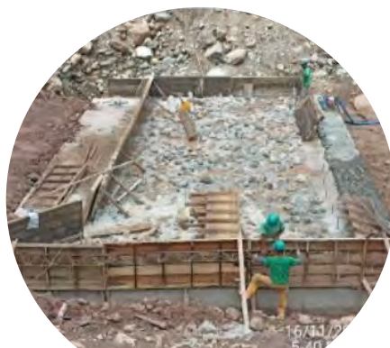
Fundición de zarpa- cimentación de azud 9
