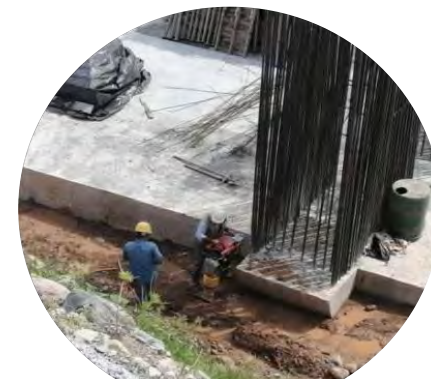
Relleno con material de sitio seleccionado
