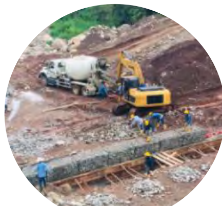
Fundición de llaves entrada y salida Dique 11
