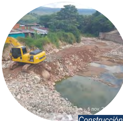
Construcción Jarillon protección Azud 15
