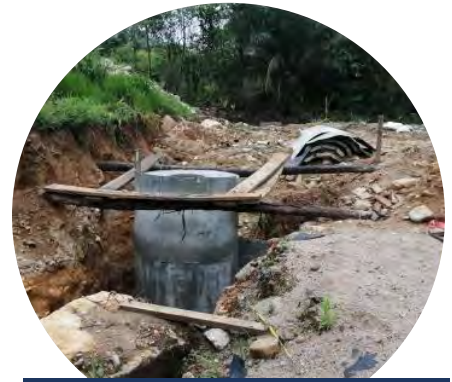
Construcción de cámaras de inspección barrios Prado Norte – Bajo Cañaverál
