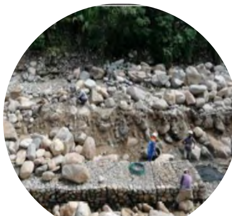
Construcción de colcho gaviones del muro No. 6
