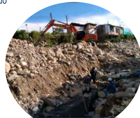
Conformación de mantenimiento de vías de acceso
