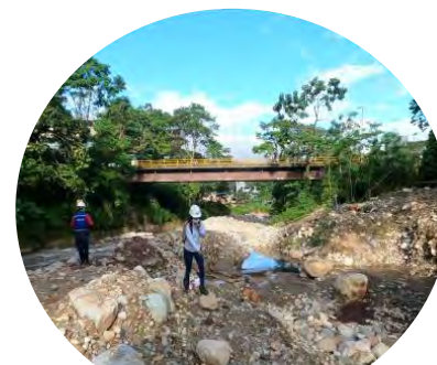
Visita al sitio de obra.
