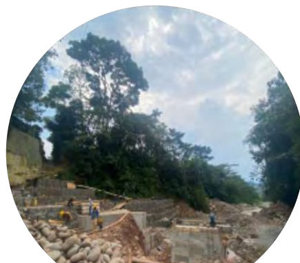
Formaleta y recubrimiento de gaviones Ribera izquierda Azud 10- Río Sangoyaco.
