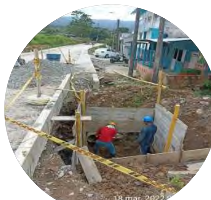
Formaleta para cámara pluvial
