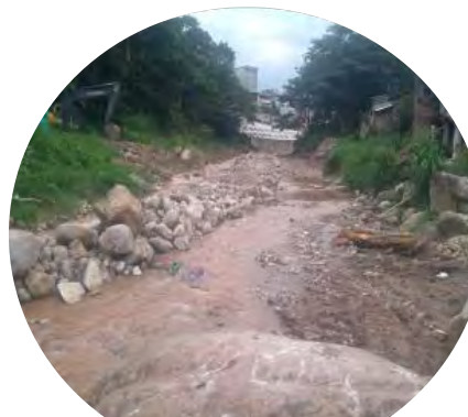
Excavaciones Azud 16 – Muro 10
