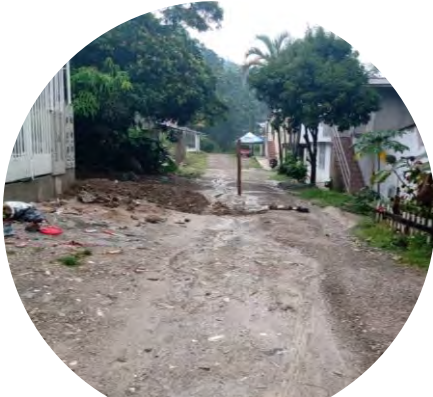
Canalización de aguas lluvias
