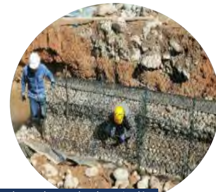
Excavaciones y construcción de gaviones de cimentación Dique Azud 4-Quebrada Taruca
