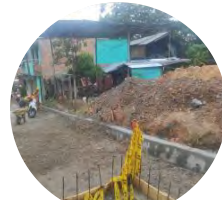
Construcción de Recamaras
