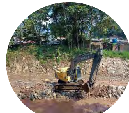
Trabajos de Ataguías para inicio excavaciones Muro 10 y Azud 16
