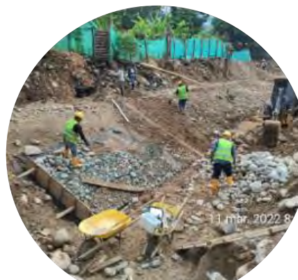
Armado de colchagaviones muro 10
