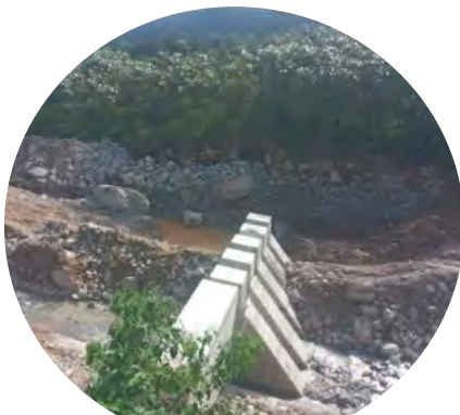
Desencofrado aleta izquierda
