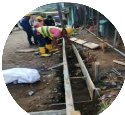
Construcción bordillos.
