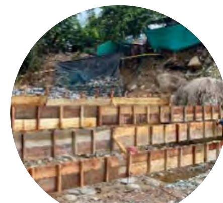
Armado de formaleta del cuerpo azud 6
