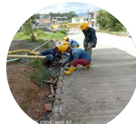
Construcción de bordillos
