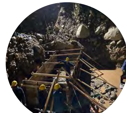
Instalación de formaletas para azud 9
