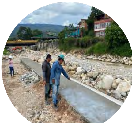
Fundición de muro 4
