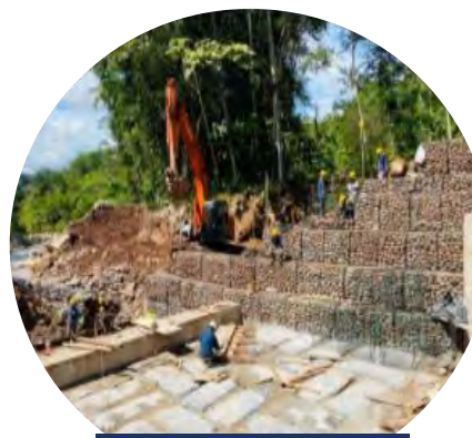
Construcción de gaviones laterales margen derecha
