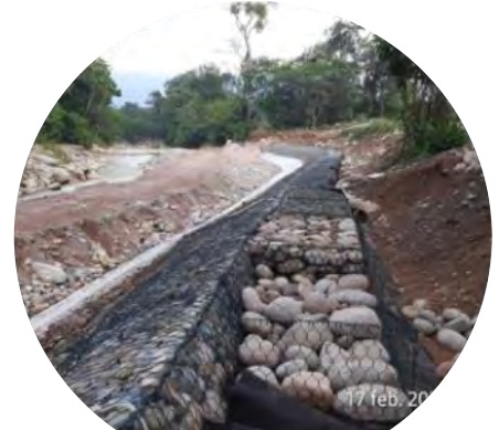
Revestimiento de colchogavión en muro 1
