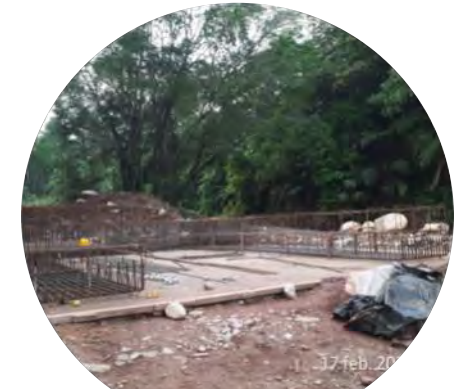
Armado de acero en la zarpa del dique 3 abierto
