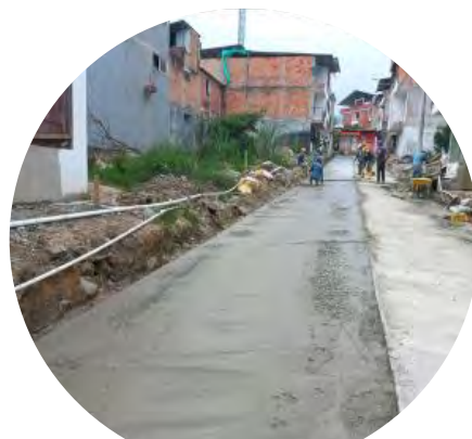
Fundición tramo 9 Quinta paredes
