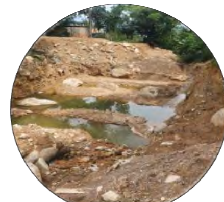
Excavaciones Azud 05 – Q. Taruca.
