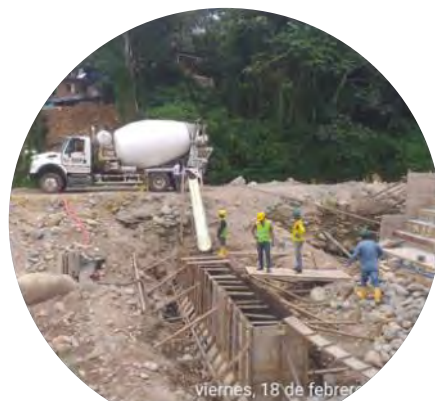
Vaciado de concreto dentellón pata de elefante, Azud 12
