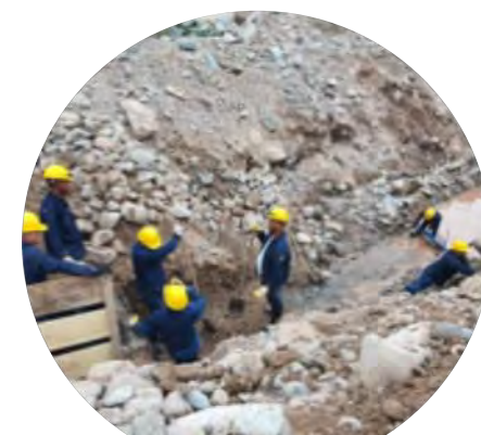
Gaviones de cimentación muro 4
