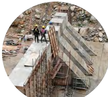
Desencofrado aleta izquierda
