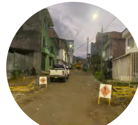
Instalación sub-base tramo 2 Quinta paredes
