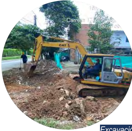
Excavación para alcantarillado
