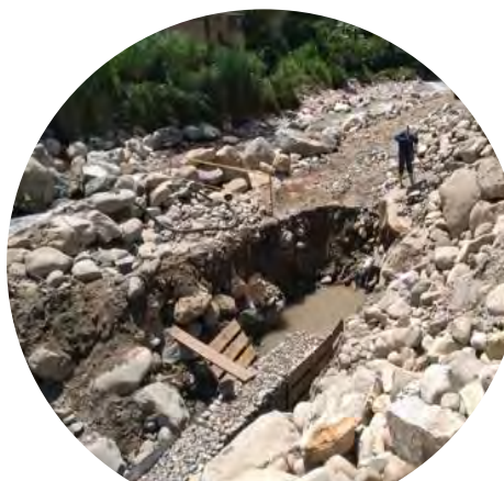
Construcción de gaviones
