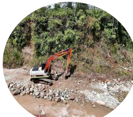
Adecuación de accesos a Obras
