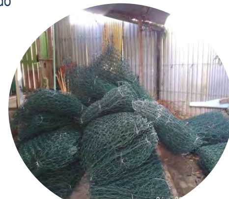
Almacenamiento de malla para colcha gavión
