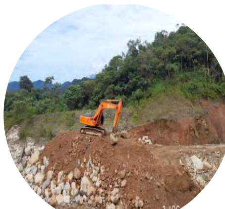
Adecuación Jarillón Temporal
