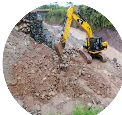
Inicio Excavaciones Jarillon 02
