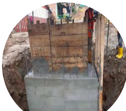
Vaciado de Concreto para cámara C5 de inspección pluvial
