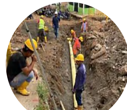
Instalación de tubería PVC 10" de sumideros
