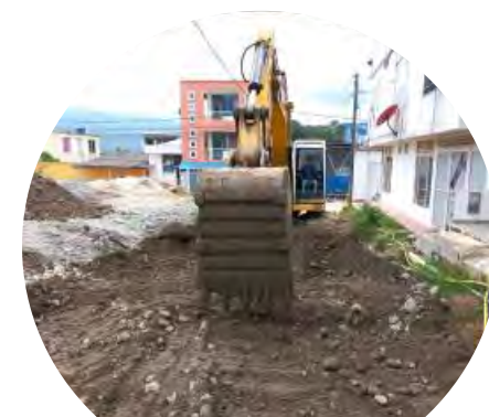
Instalación de pedraplen tramo 9 Sector Quinta paredes.
