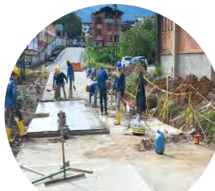
Pavimentación longitud total placa Ciudadela Deportiva.
