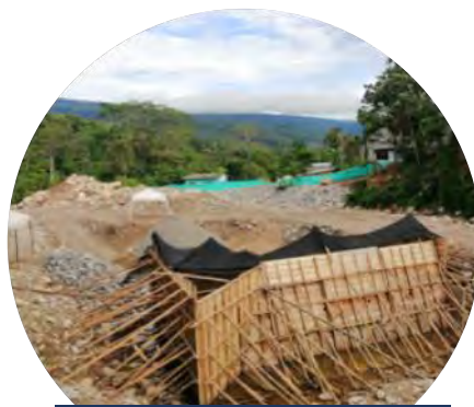
Formaleta instalada para vaciado del cuerpo y aleta completa del primer tercio, Azud 12
