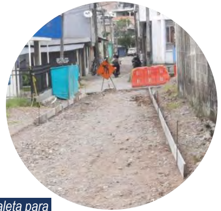
Instalación de formaleta para fundición de placas
