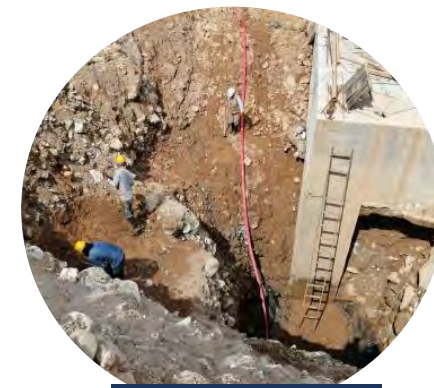
Excavación dentellón 6
