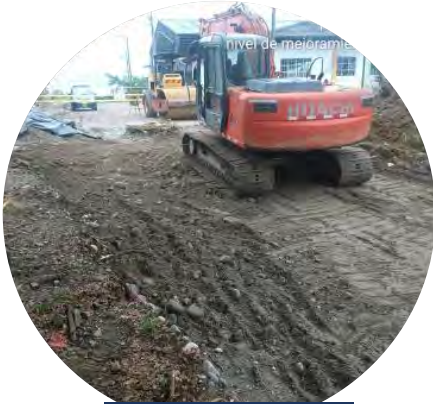
Instalación de Subbase
