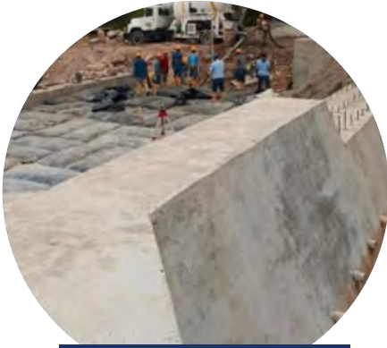
Se continua con la Instalación de Bolsacretos en el Azud 4
