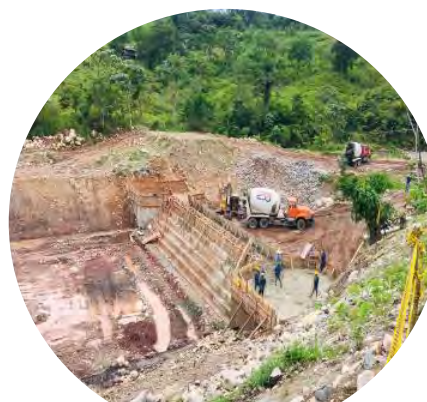
Fundición de cuerpo Dique 11
