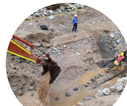
Instalación de Gaviones de cimentación Muro 10
