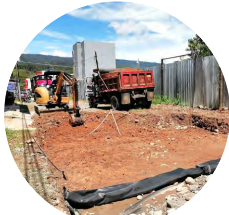
Excavación e instalación de geotextil TRAMO IV
