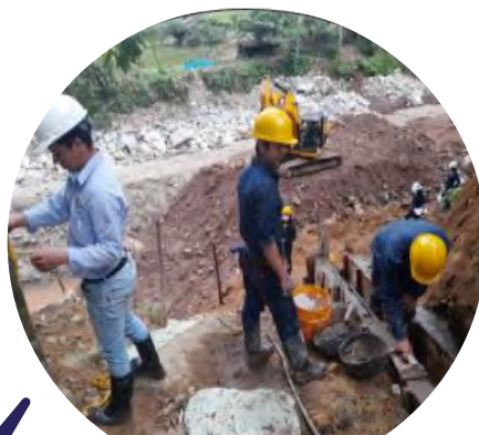
Adecuación de acceso peatonal
