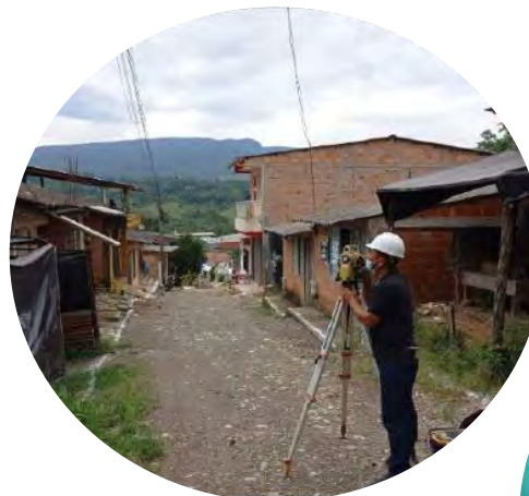
Localización y replanteo
