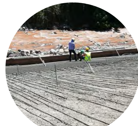
Armado de acero
