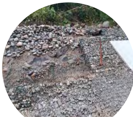
Demolición de placas de concreto de muro de protección 6 afectadas por creciente
