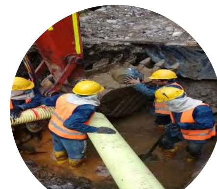
Instalación de alcantarillado
