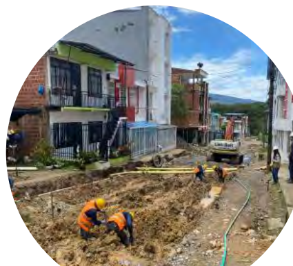
Instalación de domiciliarias B/ Quinta Paredes
