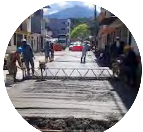
Fundición de placas en concreto TRAMO I
