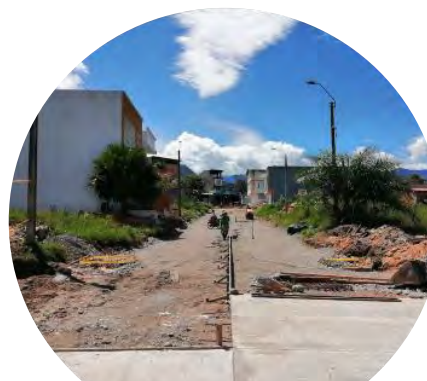
Instalación de formaleta para fundición de placas
