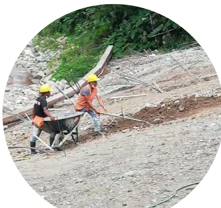
Perfilado y compactación de talud pantalla inclinada
