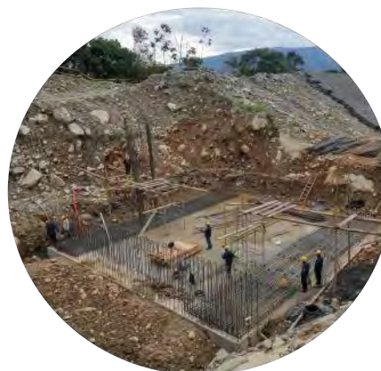
Armado de Acero
