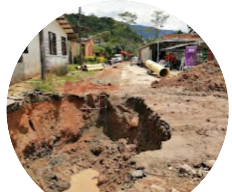
Excavación para instalación de tubería red sanitaria barrio El Carmen
