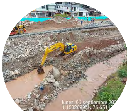
Excavación en roca y canal bajo Agua Muro 06
