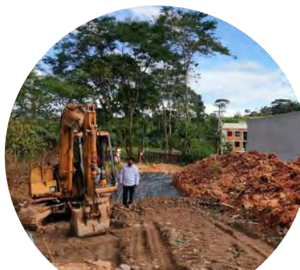
Excavación e instalación de geotextil y pedraplén
