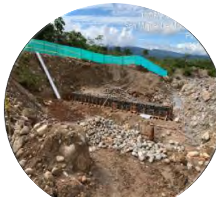
Construcción gaviones de cimentación Azud 04
