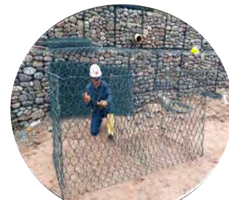
Amarre de mallas para colcha gavión
