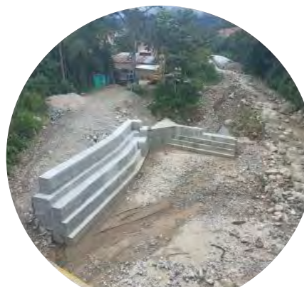
Dique tipo Azud 9
