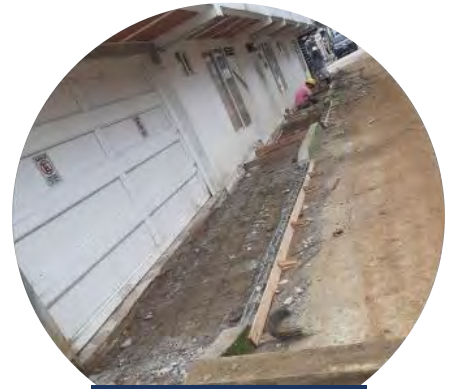
Adecuación piso andenes
