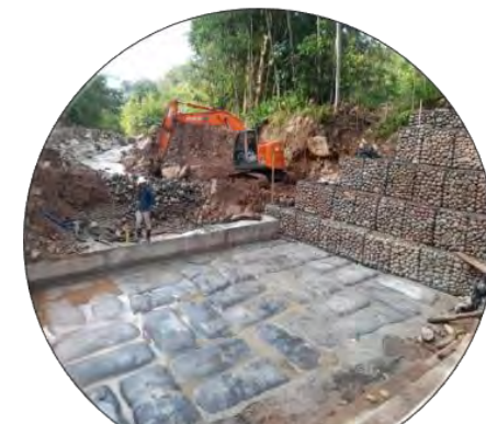
Fundición de bolsacretos margen derecha
