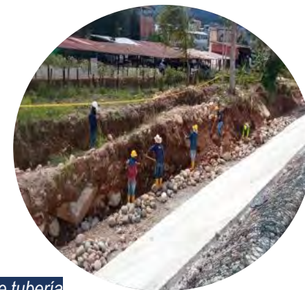
Instalación de tubería
