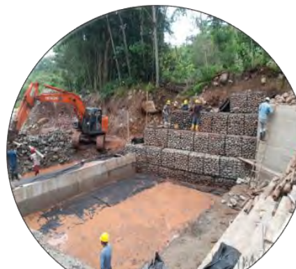
Fundición dentellón margen derecha
