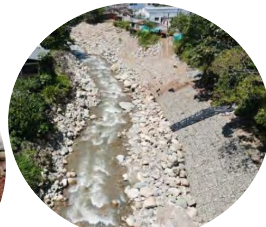
Vista del estado de la obra del muro 6
