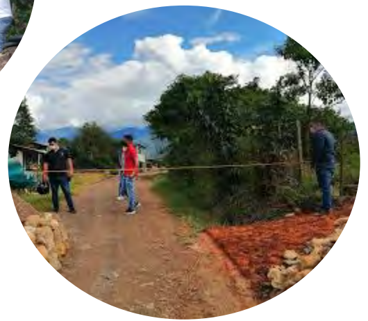
Levantamiento topográfico y verificación de líneas de paramentos
