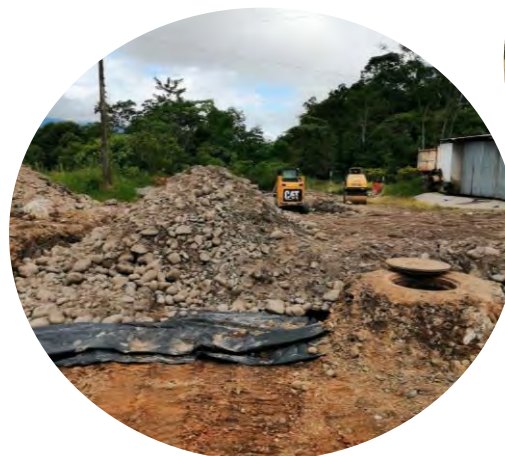
Cajeo de la vía, instalación de geotextil y pedraplén
