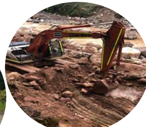
Construcción Dique Azud 13
