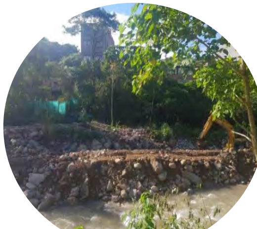
Conformación de Jarillón y manejo de cauce
