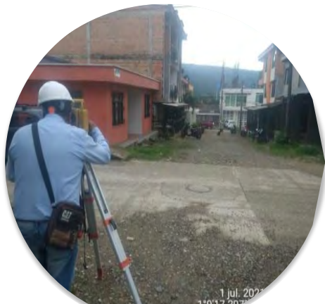
Topografía B/Obrero Etp II
