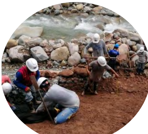
Conformación de talud muro 6, instalación geotextil y arena para colcha gavión
