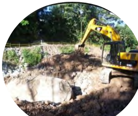
Excavación de material aluvial para tramo final de jarillón de desvío final del río
