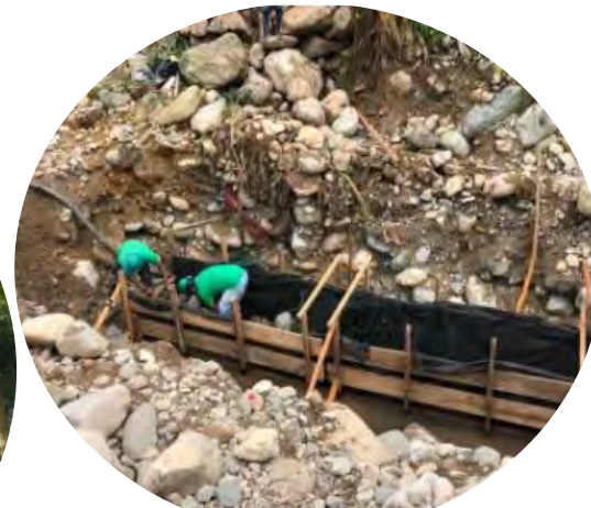
Instalación de formaleta para gavión de muro 7
