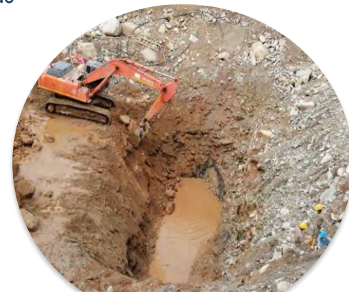
Excavación nivel de cimentación
