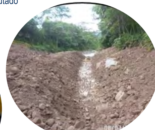
Aspecto del canal de desvío del río hacia la margen derecha
