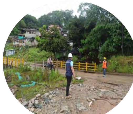
Revisión accesos Jarillón 02, Muro 06 Azud 12 y 14
