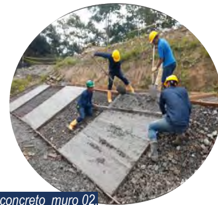
Fundición de placas en concreto muro 02.
