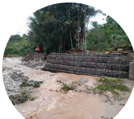
Limpieza y adecuación de zona de trabajo ribera derecha después de la creciente del río Sangoyaco (Evaluación de afectaciones) del 02 y 03 de Julio
