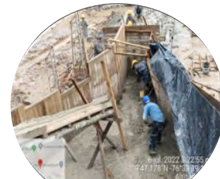
Avance fundición de primera sección de cuerpo -Azud 4
