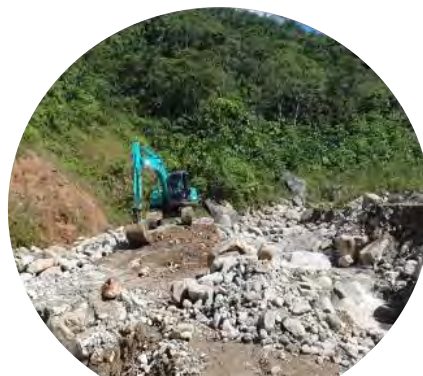
Reforzando el Jarillón de protección
