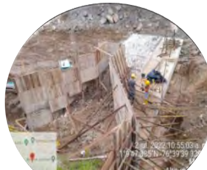
Encofrado para fundición de cuerpo primera sección de cuerpo Azud 4
