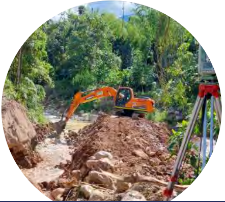
Movimiento de tierras para el nuevo cause
