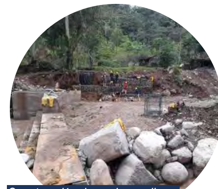
Construcción de gaviones ribera derecha
