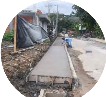
Adecuación de tramo vial
