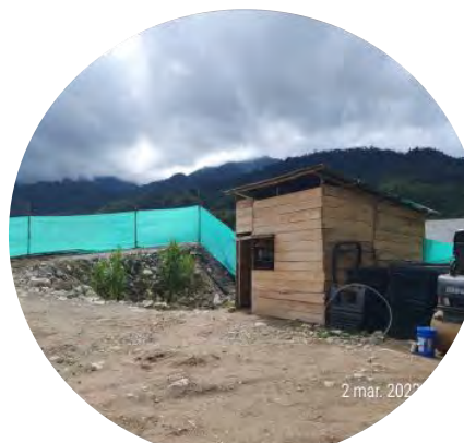
Instalación de campamento
