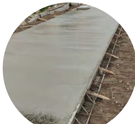
Fundición de losas de Pavimento.
