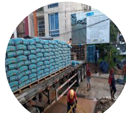
Descarga de cemento
