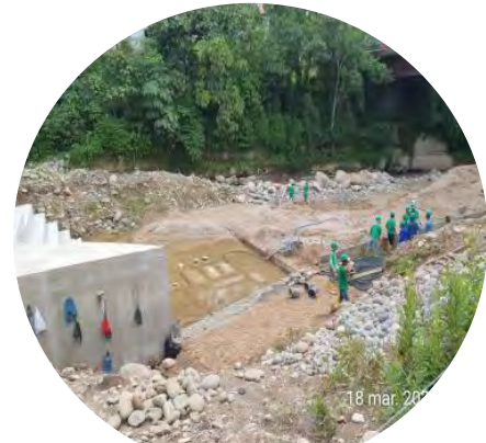
Construcción primer tercio del Azud 9
