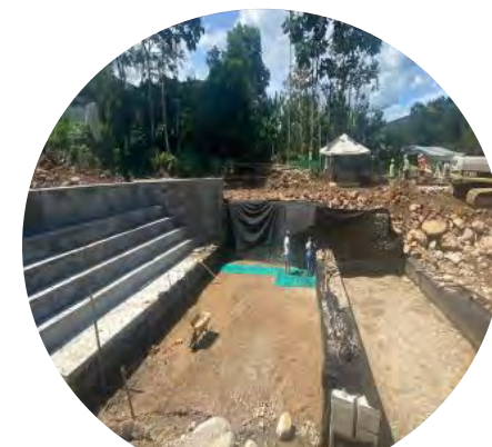
Instalación de colcha gaviones azud 6
