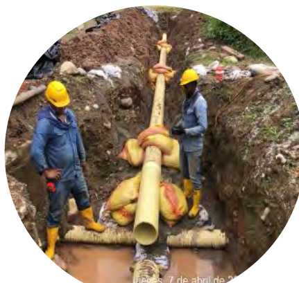
Instalación de tubería sanitaria
