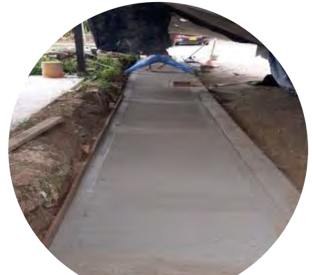
Socialización de avance de obra
