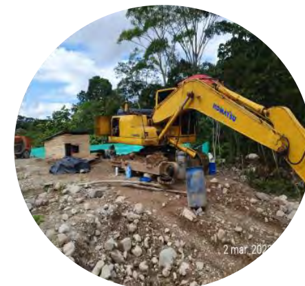
Ingreso de maquinaria
