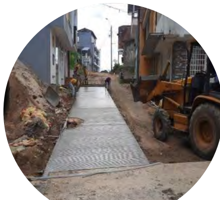
Pavimentación de un tramo
