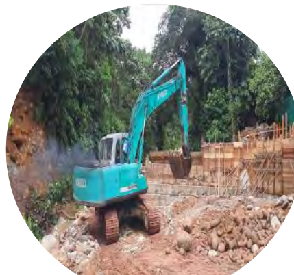
Instalación de formaletas muro 4
