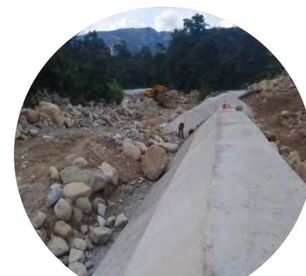
Muro 6: Recubrimiento en concreto
