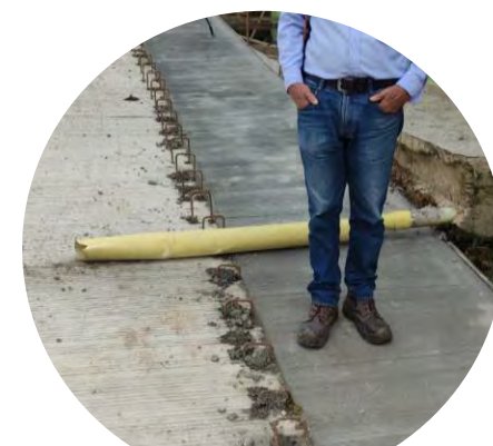
Fundición de andenes
