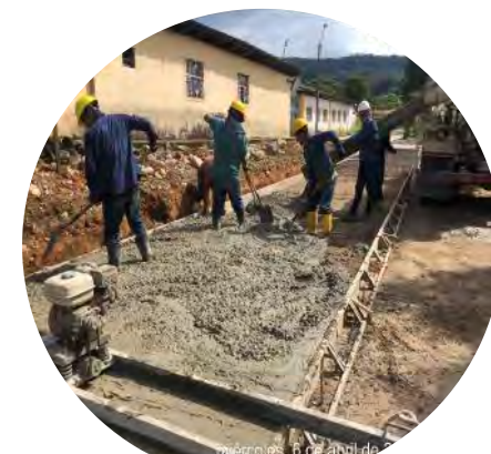
Fundición de vía
