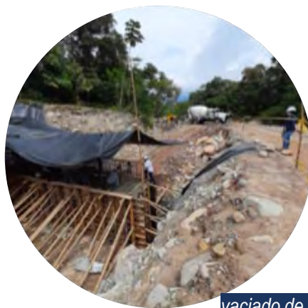
vaciado de concreto dentellón del Dique 2
