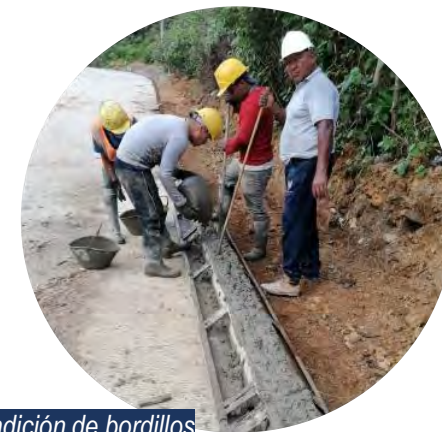
Instalación de aceros, fundición de bordillos
