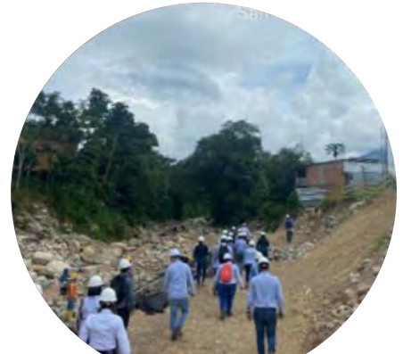
Visita técnica de evaluación, Muro 4
