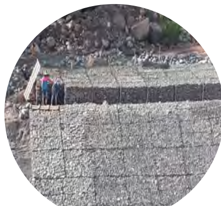
Protección lateral Derecha Dique 11
