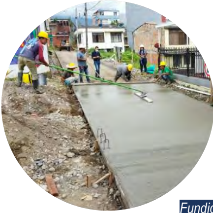
Fundición de placas
