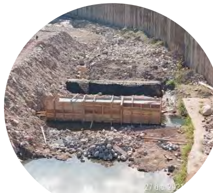
Fundición Dentellón Azud 15
