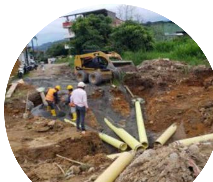
Instalación de alcantarillado Pluvial – Relleno con material seleccionado y Espacio para construcción de Cámara- Barrio Quinta Paredes
