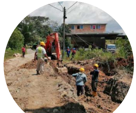
Instalación de tubería para red sanitaria barrio Prado Norte – Bajo Cañaveral
