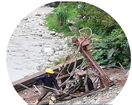
Perforación para anclajes
