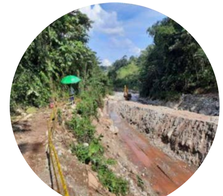
Jarillón de protección.
