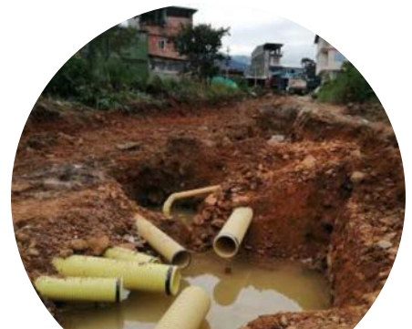
Instalación de tubería para red de alcantarillado pluvial
