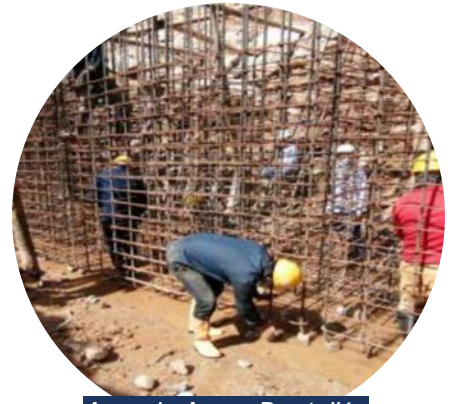
Armado Acero Dentellón
