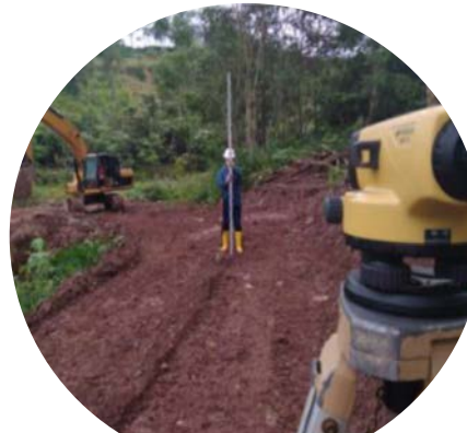
Inicio Excavaciones Azud 11
