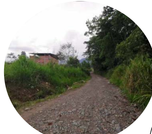
Estado inicial de la vía a intervenir
