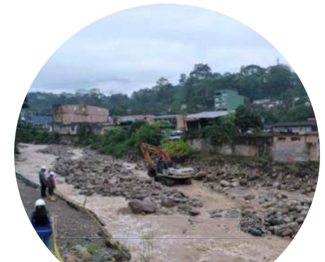
Descolmatación y recuperación del jarillón de protección del muro 6
