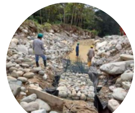
Construcción de gabiones Muro 7 - Río Mulato
