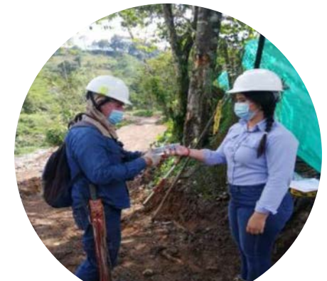
Labores de SST en obra
