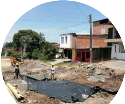
Construcción cámara de inspección y sumideros para red pluvial
