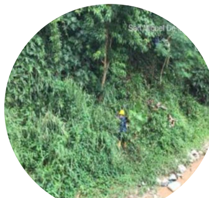
Limpeza y desmonte del área para Muro 09
