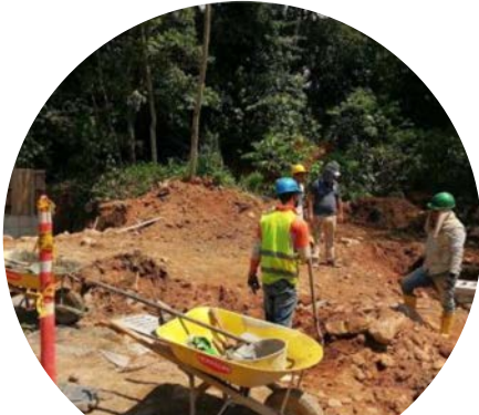
Construcción de cámaras de inspección y sumideros para red pluvial barrio El Carmen
