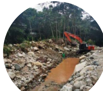
Excavación mecánica para instalación de gabiones Muro 7 – Río Mulato
