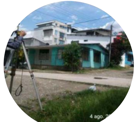
Localización y replanteo obrero II
