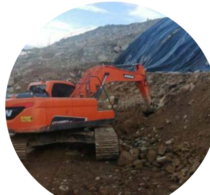
Excavación de Zarpa y aleta.
