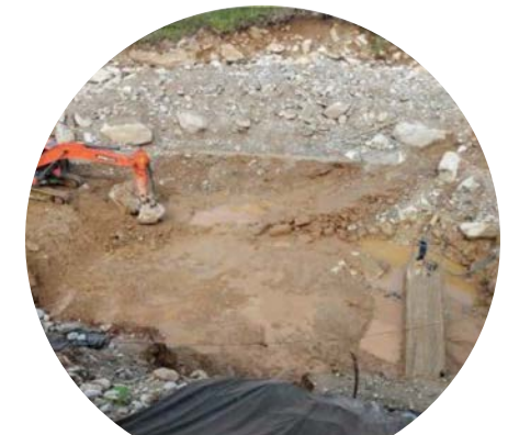
Evacuación de agua mediante bombeo
