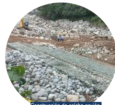
Construcción de colcha gavión para muro de protección 6
