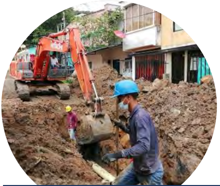
Excavación para instalación de tubería red sanitaria barrio El Carmen
