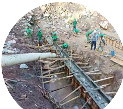
Fundición de dentellón de cimentación de azud 9
