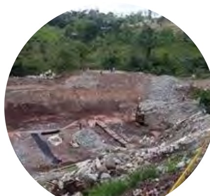
Construcción de cimentación Gavión entrada y salida azud 11
