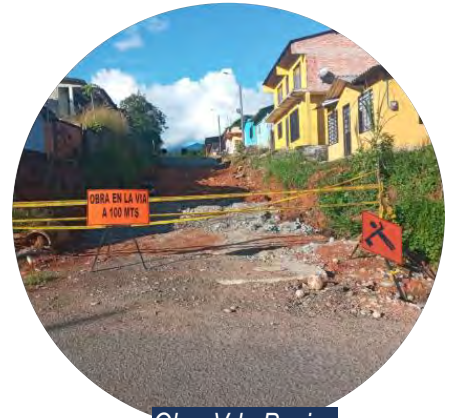
Obra Vda Pepino
