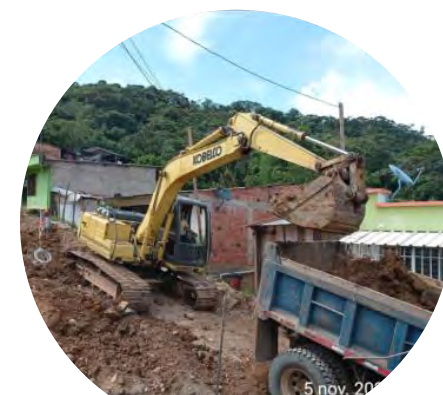
Excavación mecánica y desalojo de material sobrante
