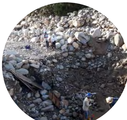
Excavación para cimentación de espolón 2
