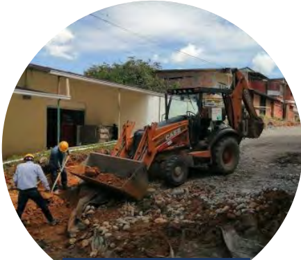
Instalación de geotextil y pedraplén
