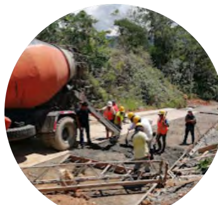
Fundición de placas
