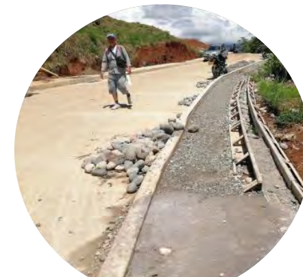
Construcción de andén
