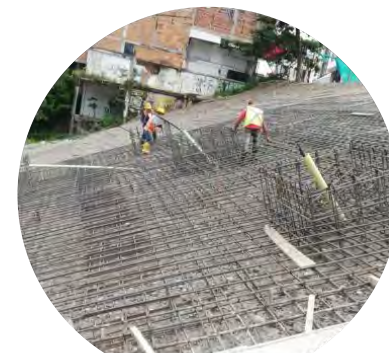
Armado de acero
