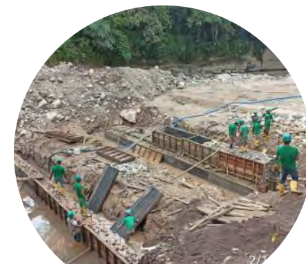
Instalación de los gaviones de cimentación del azud 9
