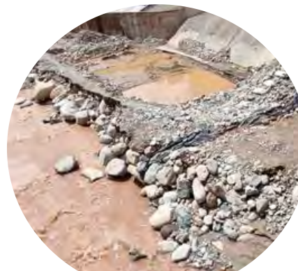
Evaluación Jarillon protección Azud 15 Posterior a creciente
