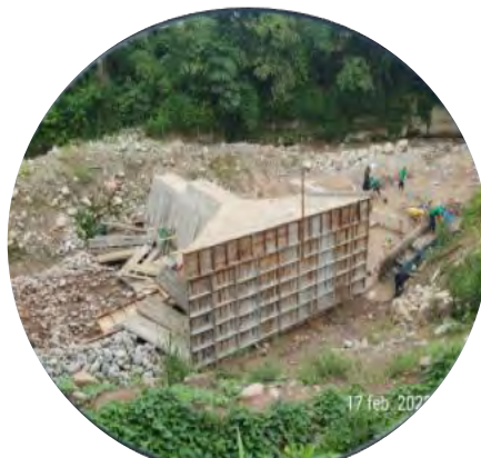
Fundición de Azud
