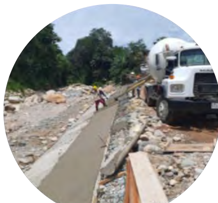
Vaciado de concreto muro 4
