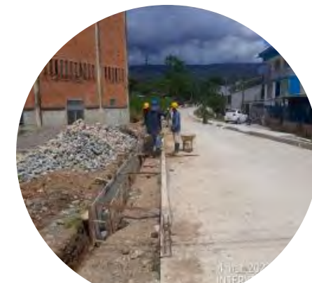
Construcción de andenes Ciudadela Deportiva
