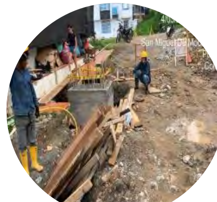
Piso cámara pluvial tramo 7 quinta paredes
