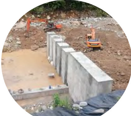
Desencofrado aleta izquierda
