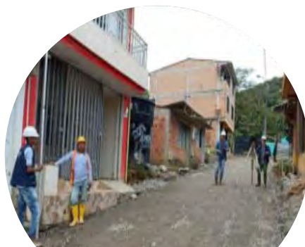
Revisión de niveles de subbase desde k0+272 hasta k0+230, con topografía de interventoría y obra.
