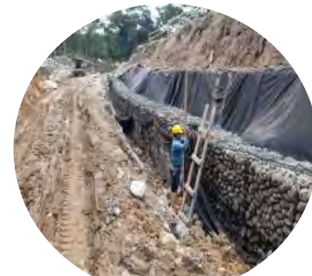
Armado Muro 2- Q. Taruca.
