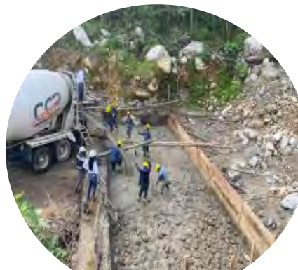
Fundición dentellones y base de cemento Azud 6-Q taruca.
