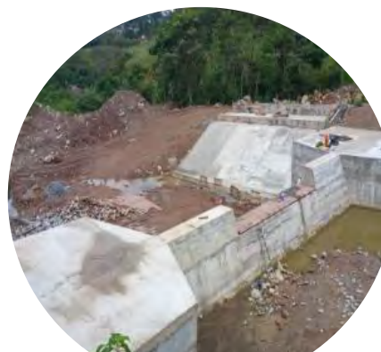
Fundida Protección lateral Izquierda Dique 11
