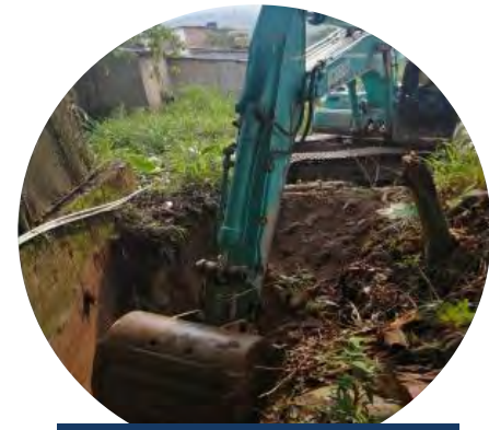
Apiques sobre muros existente verificar TR diseño
