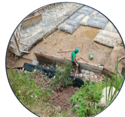
Construcción colcha gavión de protección
