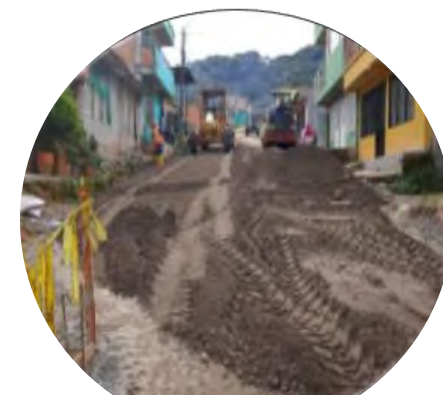
Seriado de subbase con motoniveladora
