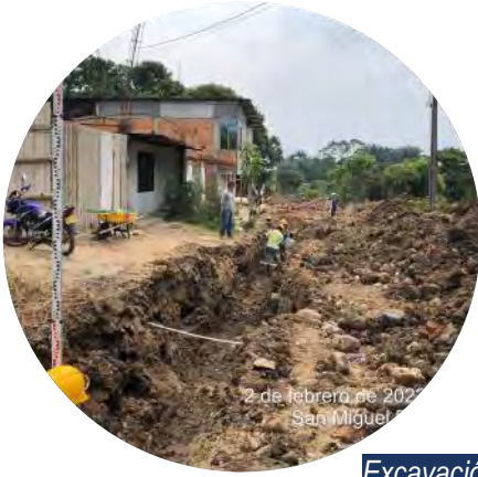
Excavación para alcantarillado
