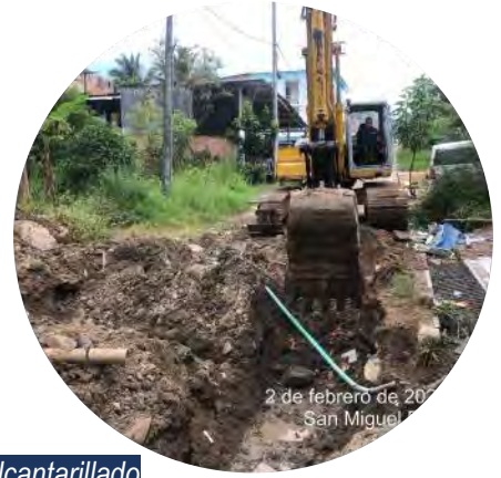
Excavación para alcantarillado
