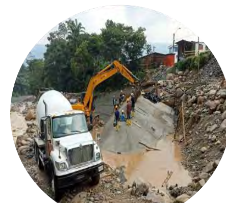
Fundición de concreto ciclópeo Espolón 2
