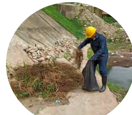
Trabajos Ambiental Azud 15
