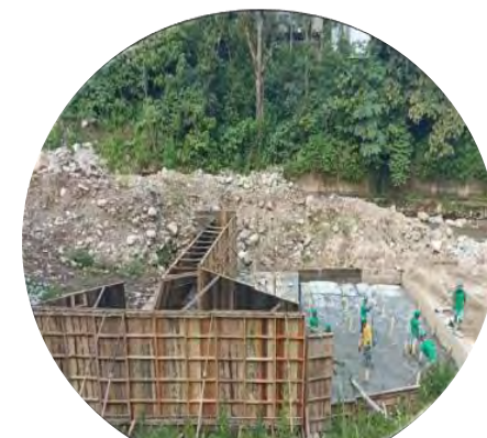
Instalación de bolsacretos
