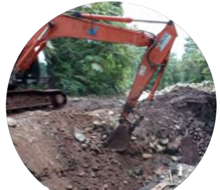
Excavación y armado de gaviones en el muro 3
