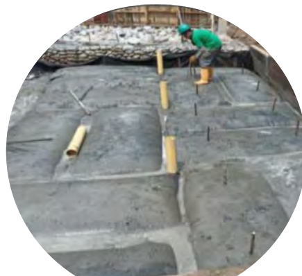
Instalación de filtros de tubería
