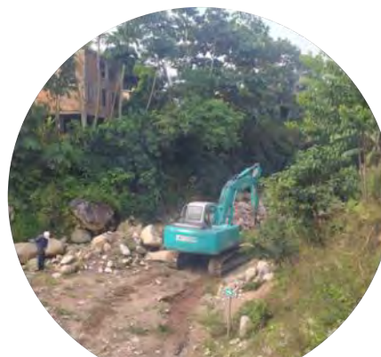
Excavación en el azud 6
