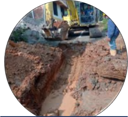
Excavación para tubería sanitaria PVC 8"
