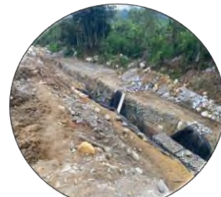
Excavaciones e instalación Muro 2-Q taruca.
