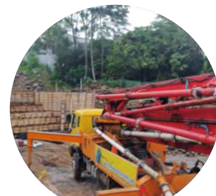
Vaciado de concreto en azud 12
