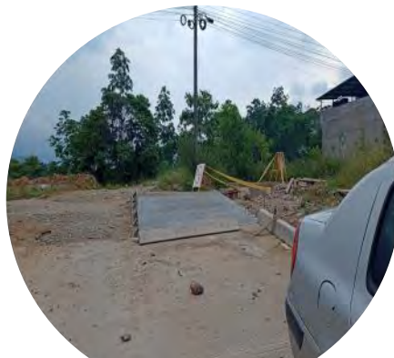
Fundición de placa de concreto intersección
