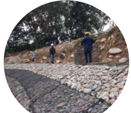
Revestimiento de colchogación en muro 1
