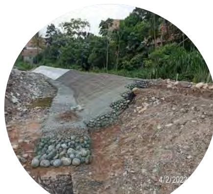
Armado de Colchagión
