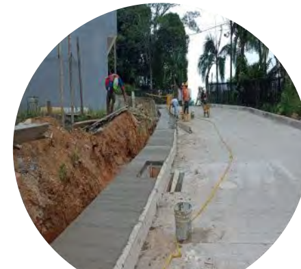
Fundición de andes margen izquierdo
