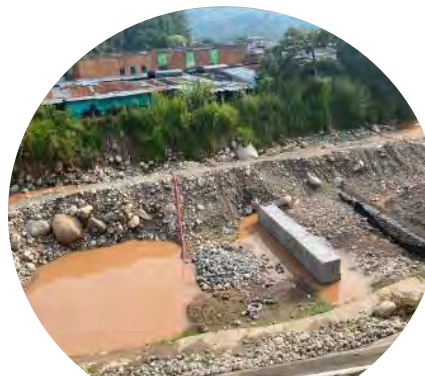
Fundición Dentellón Azud 15
