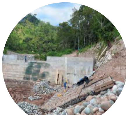
Protección lateral Izquierda Dique 11
