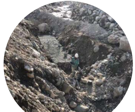
Construcción de gavión de cimentación para muro de protección 6
