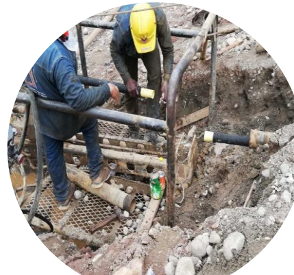
Excavación para Drenes
