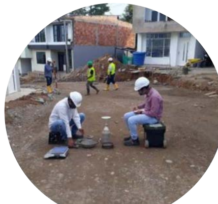
Toma de densidades en la capa de sub-base
