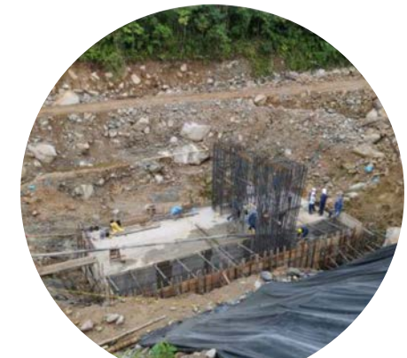
Vaciado de concreto módulo 3
