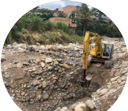
Excavación mecánica para localización de gaviones cimentación del muro de protección 6
