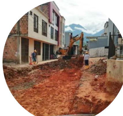
Cajeo de vía
