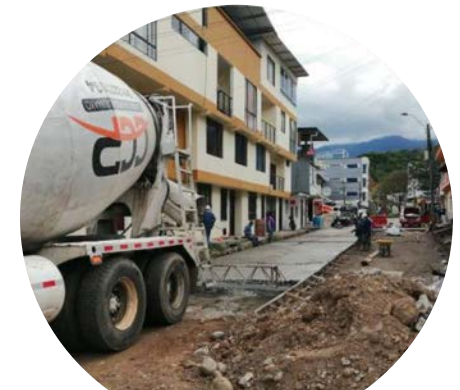
Fundición de placas en concreto
