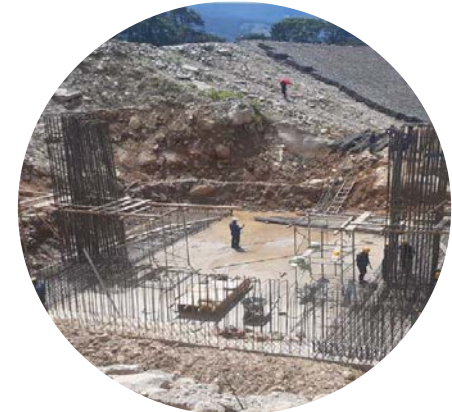
Armado de Acero
