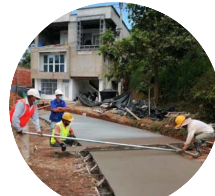
Fundición de placas en concreto
