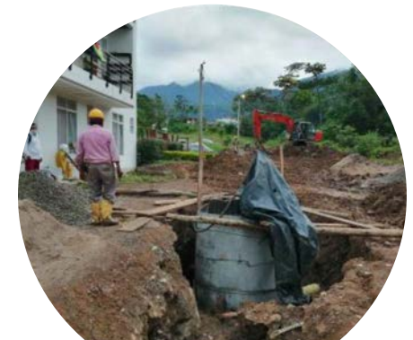
Instalación de formaleta para cámaras barrios Prado Norte – Bajo Cañaverál
