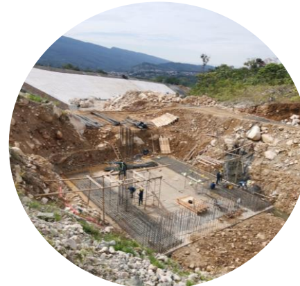
Armado de Acero
