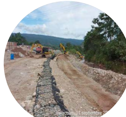
Gaviones Anclaje Muro 06
