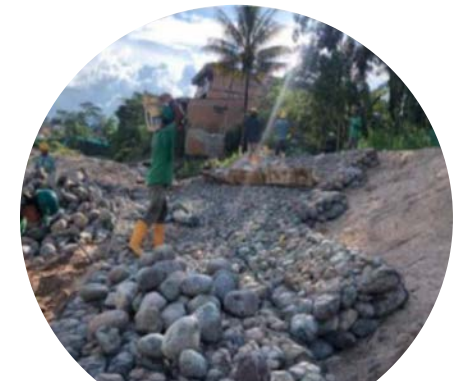
Construcción de colcha gaviones para el Muro de protección 7
