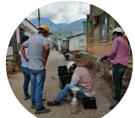
Toma de densidades en la capa de sub-base
