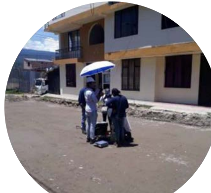
Toma de densidades en la capa de sub-base
