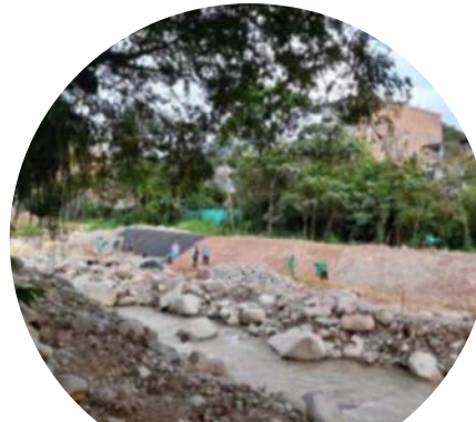
Instalación de geotextil para el muro de protección 7
