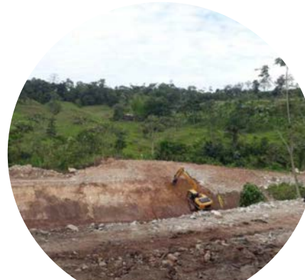
Inicio Excavaciones Azud 11
