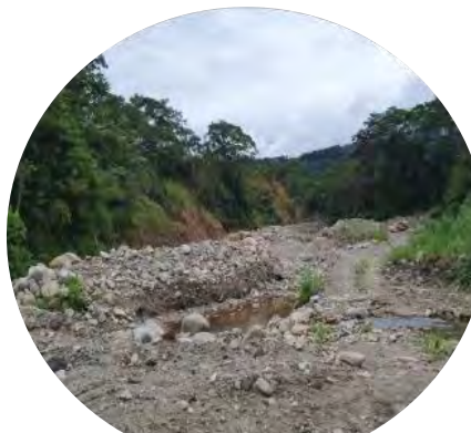
Adecuación de terreno para Construcción de azud 9
