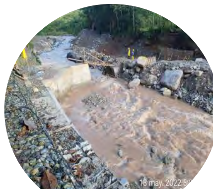
Gaviones laterales margen izquierda
