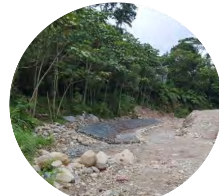
Gaviones laterales muro 03
