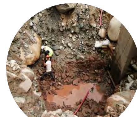
Excavaciones módulos 5,6 y 7 Dique 2 abierto río Mulato
