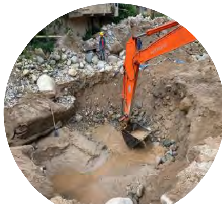
Excavación de material azud 7
