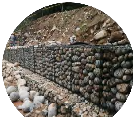
Instalación de gaviones de protección margen izquierda
