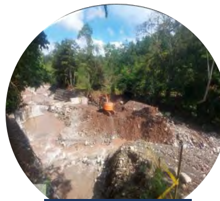
Movimiento de material de protección ribera derecha
