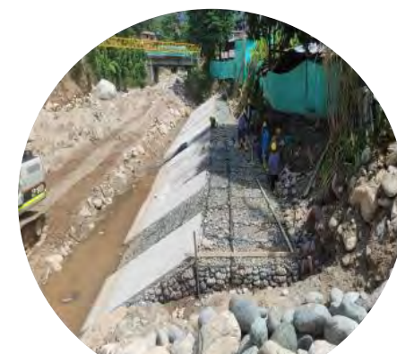
Fundición de corona de muro
