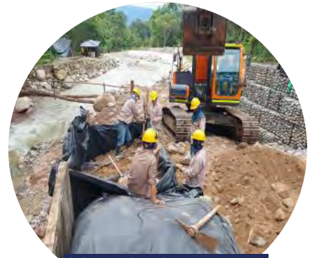
Adecuación de terreno para instalación de bolsacretos
