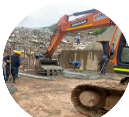
Fundición de cemento
