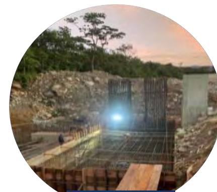
Instalación de aceros para nuevos módulos
