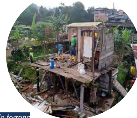
Adecuación de terreno
