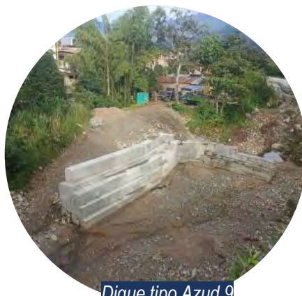
Dique tipo Azud 9
