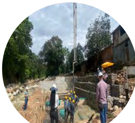
Instalación de bolsacretos
