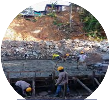
Fundición cimentación azud 5
