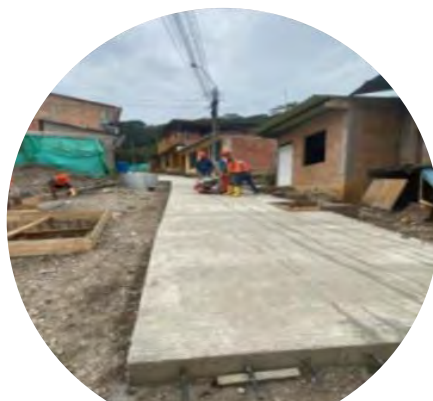
Corte de Juntas del Pavimento.
