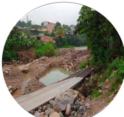
Muro 7: Construcción de Colchagaviones y Fundición de Recubrimiento en Concreto.
