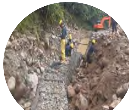
Instalación de gaviones de cimentación Muro 3-Río Sangoyaco.
