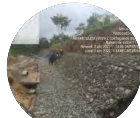
Instalación de gaviones de cimentación y de colchogavión en Muro 2-Quebrada Taruca.
