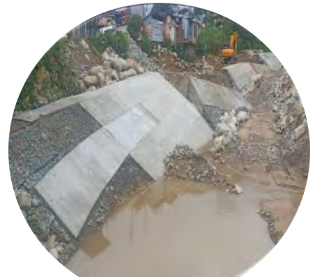
Muro 6: Recubrimiento en concreto
