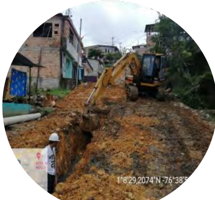
Excavación para alcantarillado
