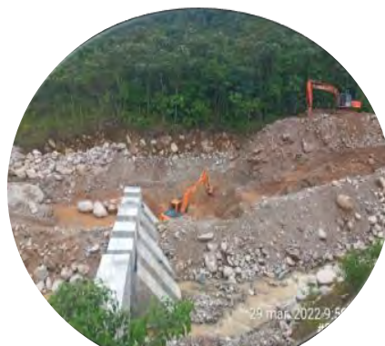
Excavaciones para dentellón
