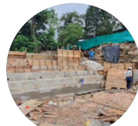
Formaletas en el azud 6
