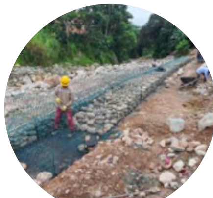
Armado de colchagaviones muro 4
