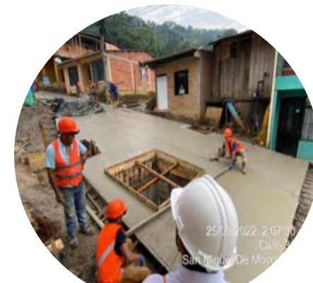
Fundición de Losas de Pavimento
