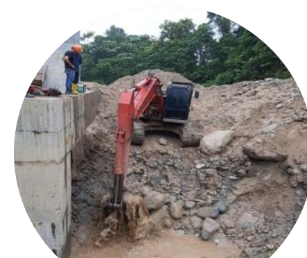
Excavaciones módulos 5,6 y 7 Dique 2 abierto río Mulato
