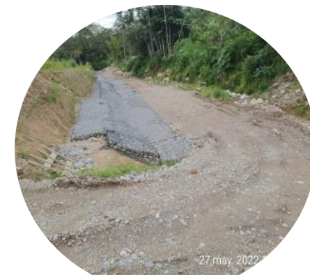
Azud 6 quebrada Taruca
