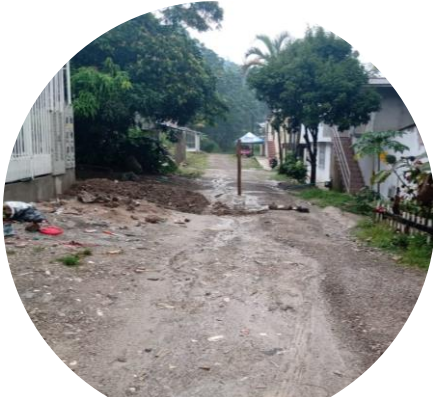
Canalización de aguas lluvias
