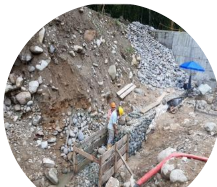
Instalación de gaviones de cimentación Margen izquierda
