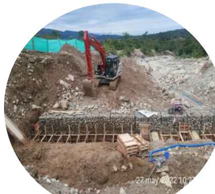
Instalación de gaviones dique 4
