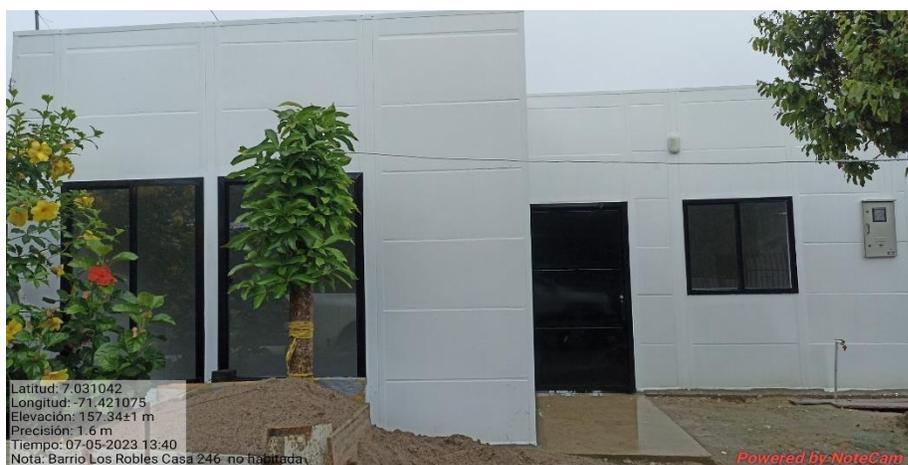
**Imagen 17.** CASA 246 BARRIO LOS ROBLES. Ingreso de agua en la entrada por desnivel losa, por ventanas tipo V-2 cuarto principal y por empalme tejas de cubierta / **Fuente:** Visita Técnica
