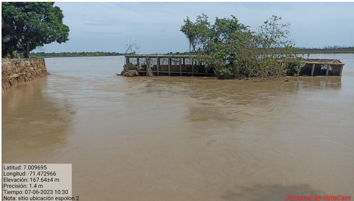
**Imagen 47.** Colapso de Estructura de emergencia E2', se observa la pérdida de la estructura de reconexión que, según informes de obra e interventoría, se había ejecutado para reconectar la estructura metálica 2 con el dique carretable existente, en el que se observa pérdida de banca de la vía antigua entre Saravena y Arauquita. Por lo cual, la
