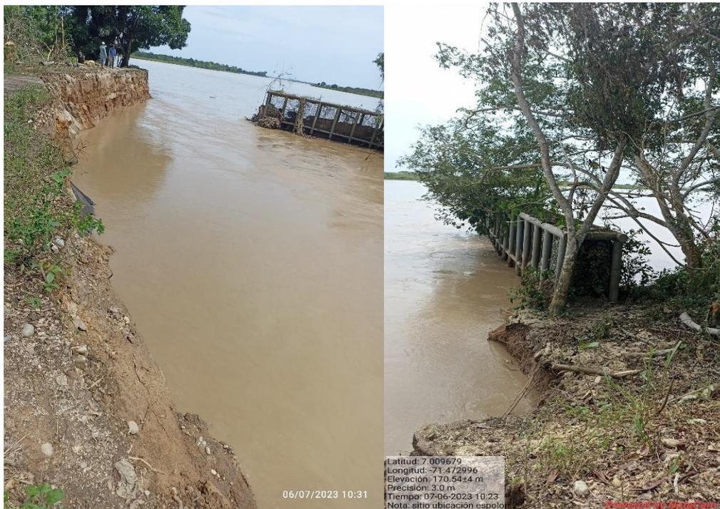
**Imagen 48.** Colapso de Estructura de emergencia E2', se observa la pérdida de la estructura de reconexión que, según informes de obra e interventoría, se había ejecutado para reconectar la estructura metálica 2 con el dique carretable existente, en el que se observa pérdida de banca de la vía antigua entre Saravena y Arauquita. Por lo cual, la estructura metálica 2 se está sumergiendo y con riesgo de colapso.
