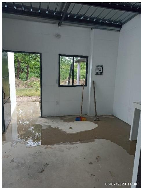
**Imagen 13. CASA 66 BARRIO BRISAS DEL LLANO.** Ingreso de agua en la entrada por desnivel Losa
