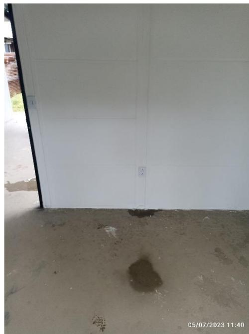
**Imagen 16.** CASA 66 BARRIO BRISAS DEL LLANO. Ingreso de agua empalme tejas cubierta / **Fuente:** Visita Técnica
