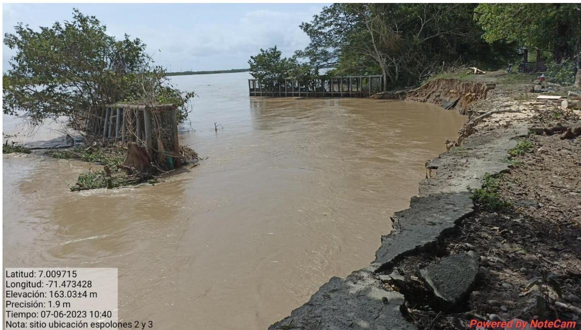
**Imagen 46.** Colapso de Estructura de emergencia E2' y Estructura de emergencia E3', ejecutada en el contrato según informes de obra, para reconectar las estructuras metálicas 2 y 3. Se observa pérdida de banca de la vía antigua entre Saravena y Arauquita.
