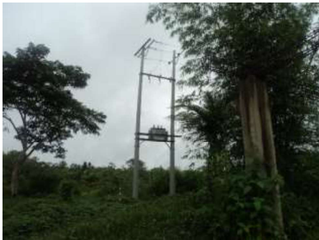
Red media tensión y transformador
