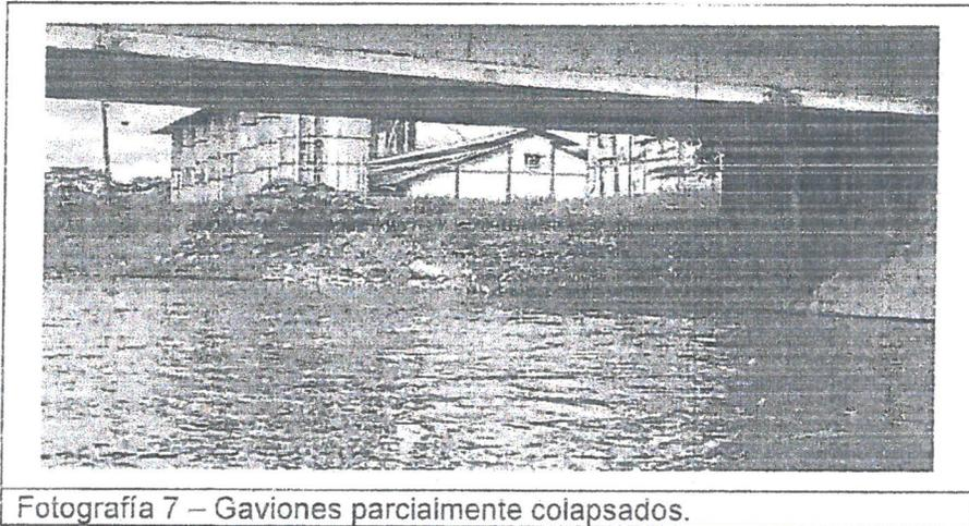
Fotografía 7 – Gaviones parcialmente colapsados.
