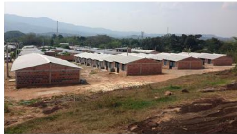
Construcción de 117 viviendas –Barrio Villa Alejandra y Subestación Ataco – Tolima
