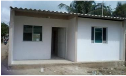
Construcción de 80 viviendas –Barrio Nueva Esperanza Sincelejo – Sucre
