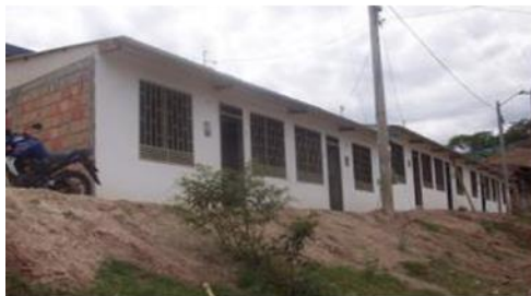
Suministro de materiales para la construcción de 158 viviendas -Barrio Centenario y Convivir Timaná – Huila
