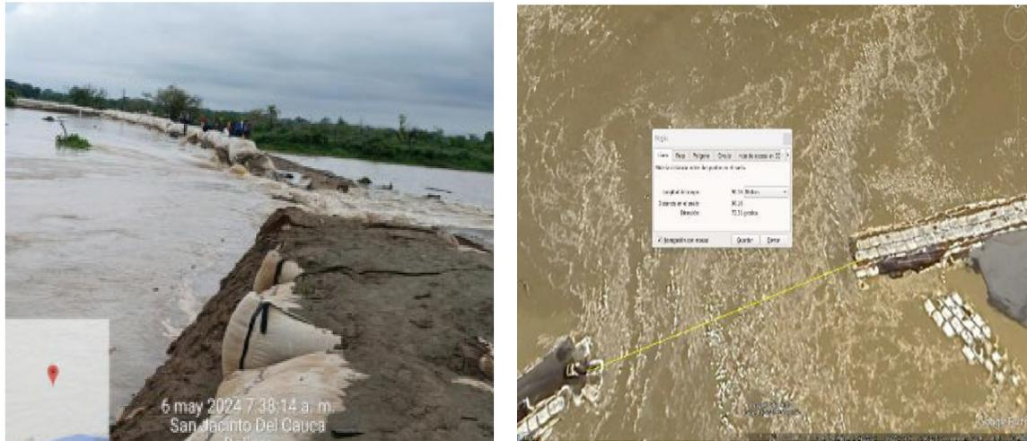
*Fotografía 31. Registro fotográfico del 6 de mayo de 2024 a las 7:37am en el sitio del boquete (izq). Ancho del boquete de 90 m el 12 de mayo de 2024 entre las abscisas k0+700 y k0+790 (der).*
