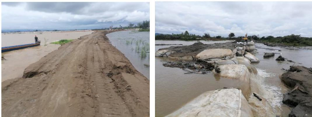
Fotografía 30. Condiciones de la obra ejecutada a 04/05/2024. Dique preliminar con borde libre de 0.30m y surcos de erosión (izq). Flujo sobre la cresta del dique entre las abscisas K0+000 y K0+300 (der).
