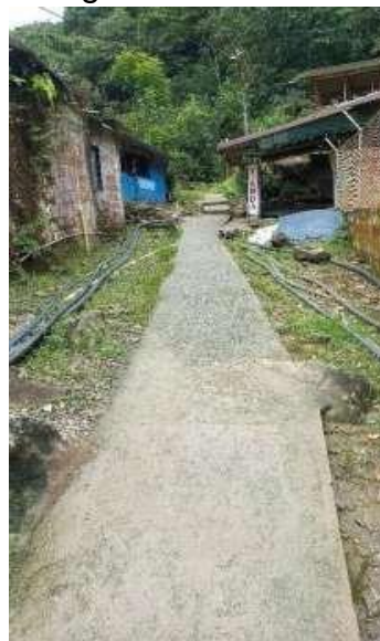
Vía El Salto
