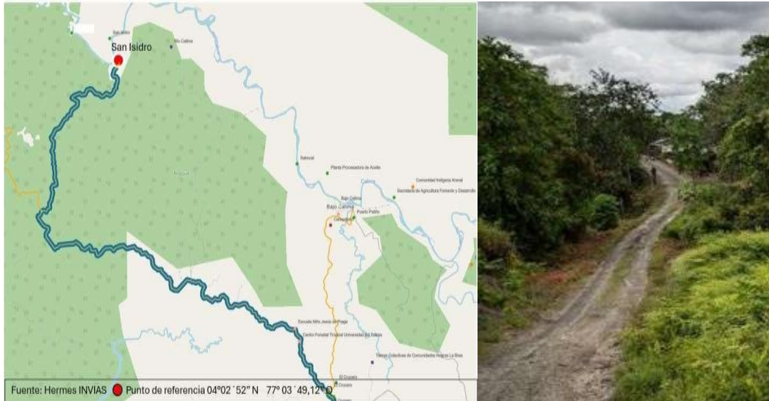
Ubicación vía San Isidro y estado de la vía.
