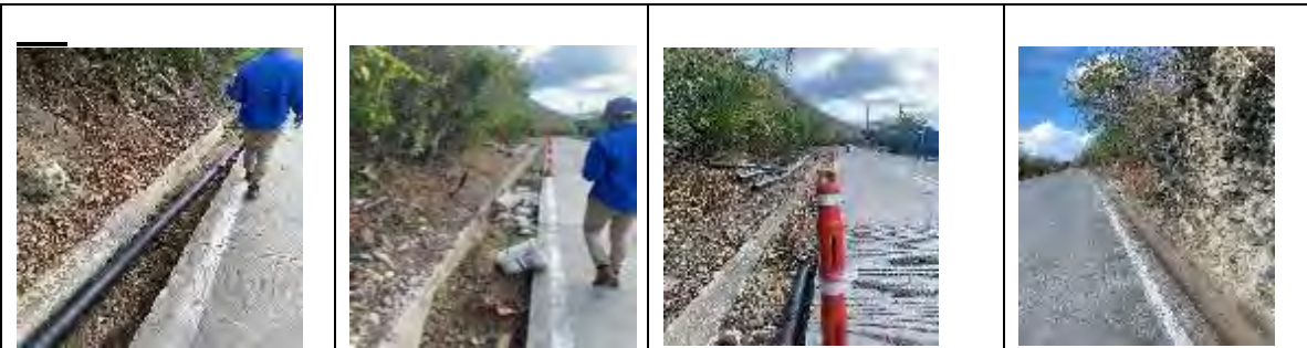
Sector 3 – Instalación de tubería
