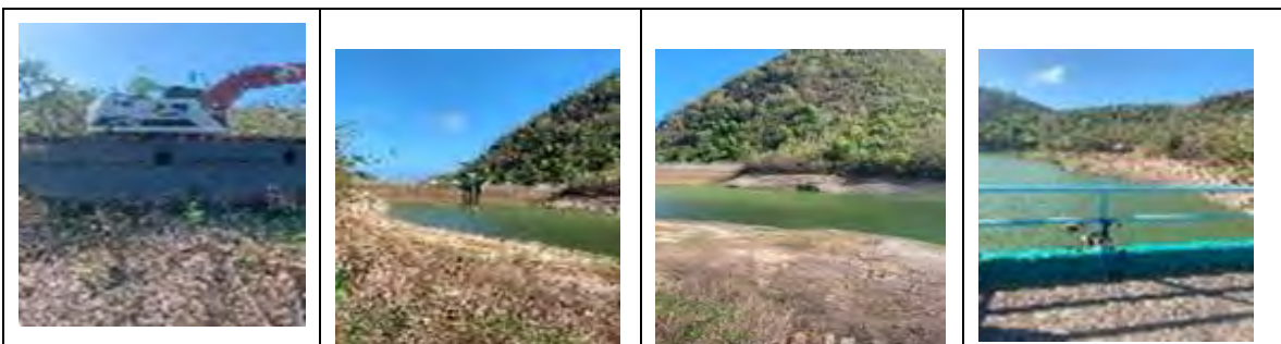
Maquinaria Suministrada por la UGR, Vía de acceso para dragado
