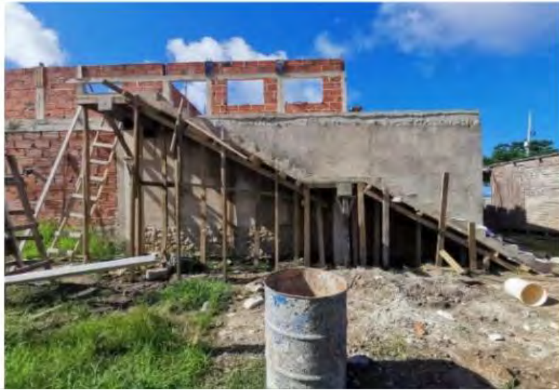
Fuente: Visita realizada a la isla
