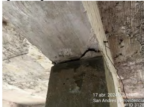
Imagen No. 5 - Registro fotográfico de la visita de la CGR del 17 abril de 2024
