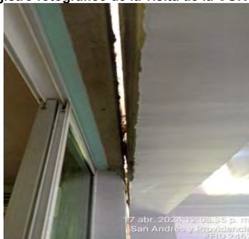
Imagen No. 6 - Registro fotográfico de la visita de la CGR del 17 abril de 2024
