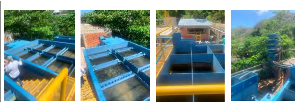
Módulo 1 y 2 en la PTAP (Floculación y sedimentación) – Tanque de Cloración – Zonas de Filtro – Bandejas de Aireación
