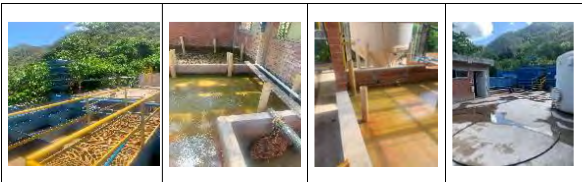
Módulo 1 y 2 en la PTAP (Floculación y sedimentación) – Tanque de Cloración – Zonas de Filtro – Bandejas de Aireación
