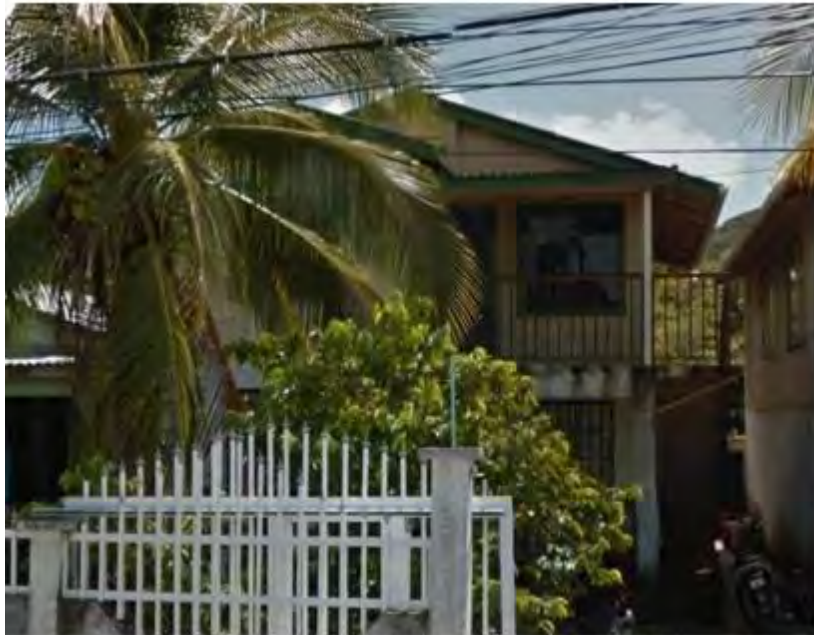
Fuente: Imagen de la vivienda antes del paso del Huracán Iota
