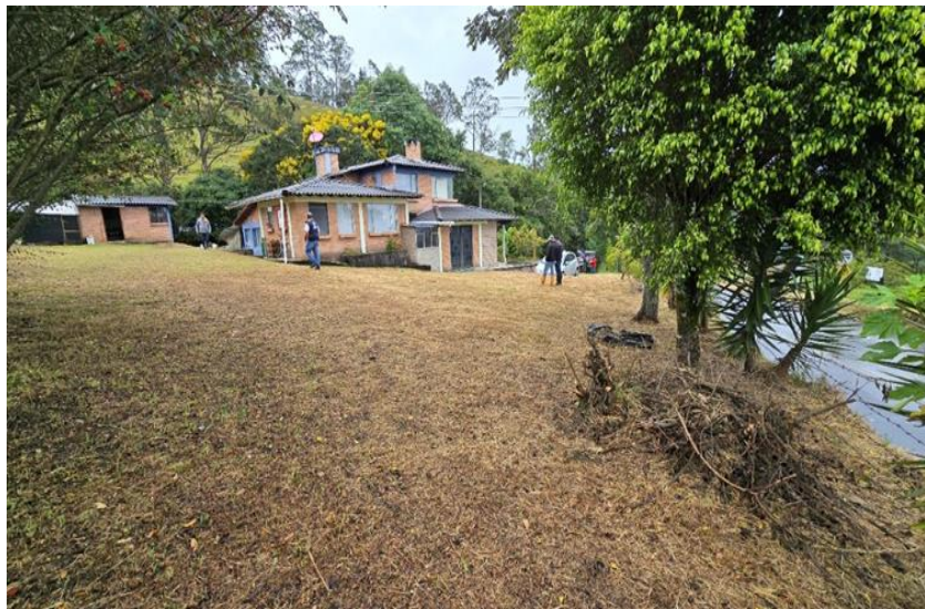
Imagen 6. Código predial 52480000100171142 Edificación sin demoler, destinado para capilla
