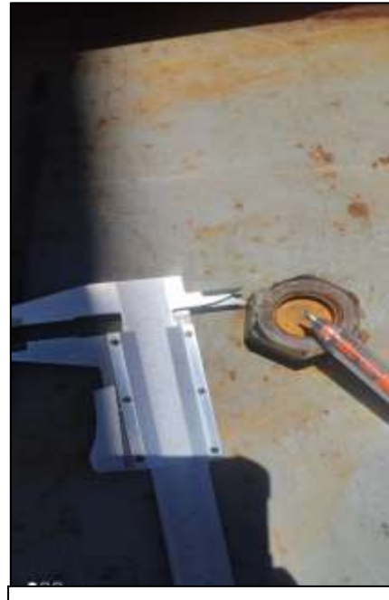
Fotografía N.4. Torque incompleto, pernos de transferencia. Fecha: 30 sept.-22
