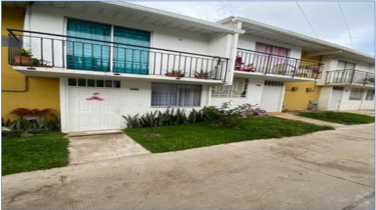
Fotografía 5: Sauces I. Viviendas sin modificaciones
