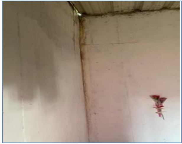
Fotografía 3: Fisuras en muros y cubierta
