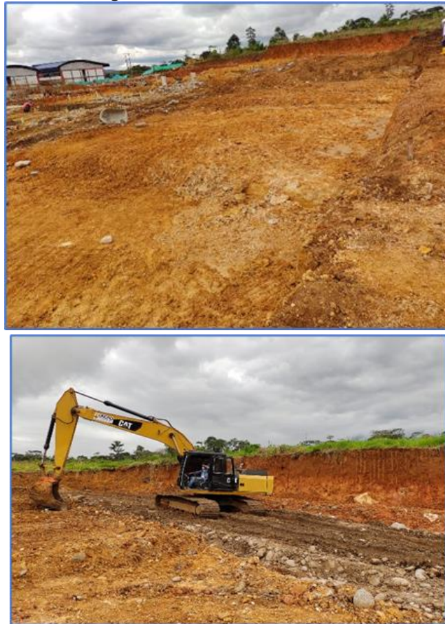
Fotografía 14: Movimientos de tierra
