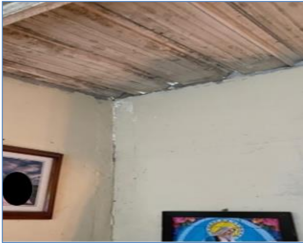
Fotografía 3: Fisuras en muros y cubierta
