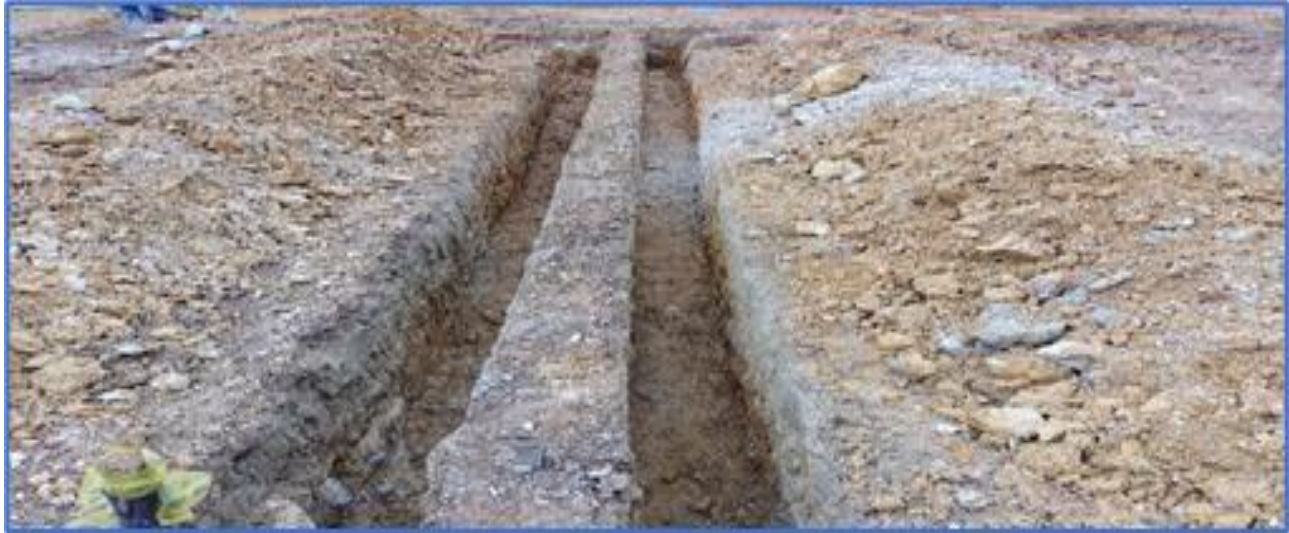
Fotografía 15: Cimentaciones y redes
