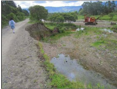
Fotografía 1. Estado actual, sitio ejecución muro (5-may-2014)
