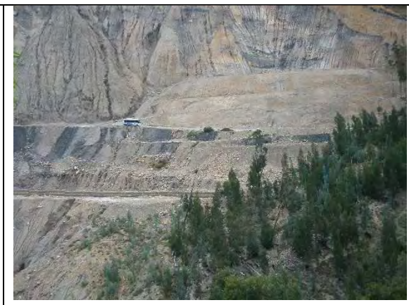
Fotografía 4. Terrazas y gaviones
