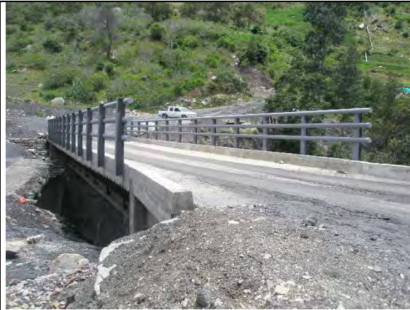
Fotografía 1. Vista general puente en concreto reforzado sector la Tabla
