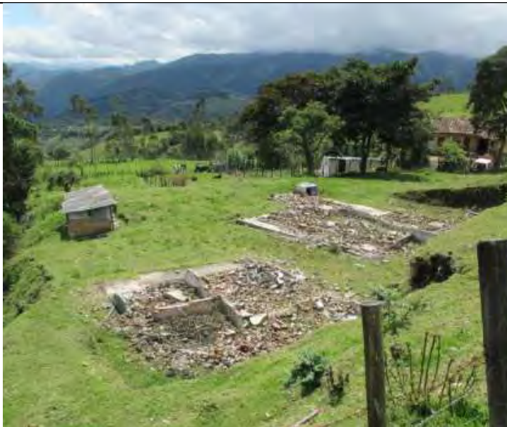
Foto No. 3. Vivienda demolida de la ZAVA
